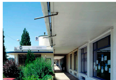
Vue de détail : le portique. Phot. Thierry Petitberghien IVR31_19945901139ZA
