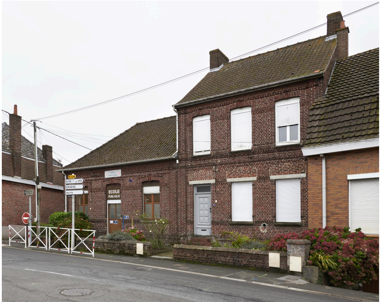
Façade sur rue, vue depuis le nord-ouest.
