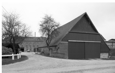
Vue générale depuis la rue : la grange et le logis. Phot. Christiane Riboulleau IVR22_19960200441Z
