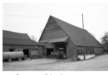
Grange : élévation sur cour. Phot. Christiane Riboulleau IVR22_19960200437Z
