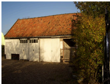
Vue des dépendances. Phot. Inès Guérin IVR22_20068005611NUCA
