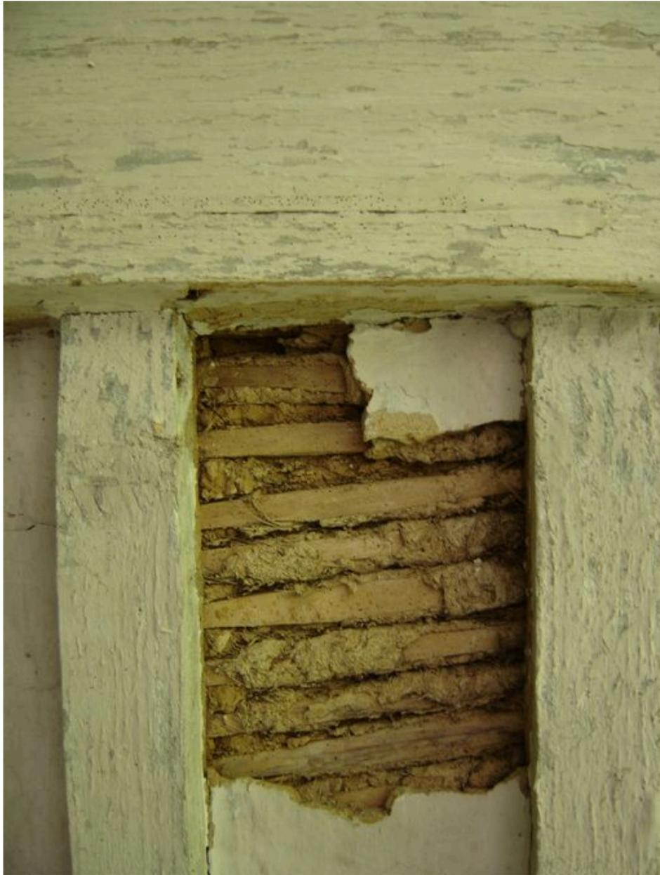
Détail de la composition du plafond des boxes en torchis enroulé autour de lattes placées entre les solives.
