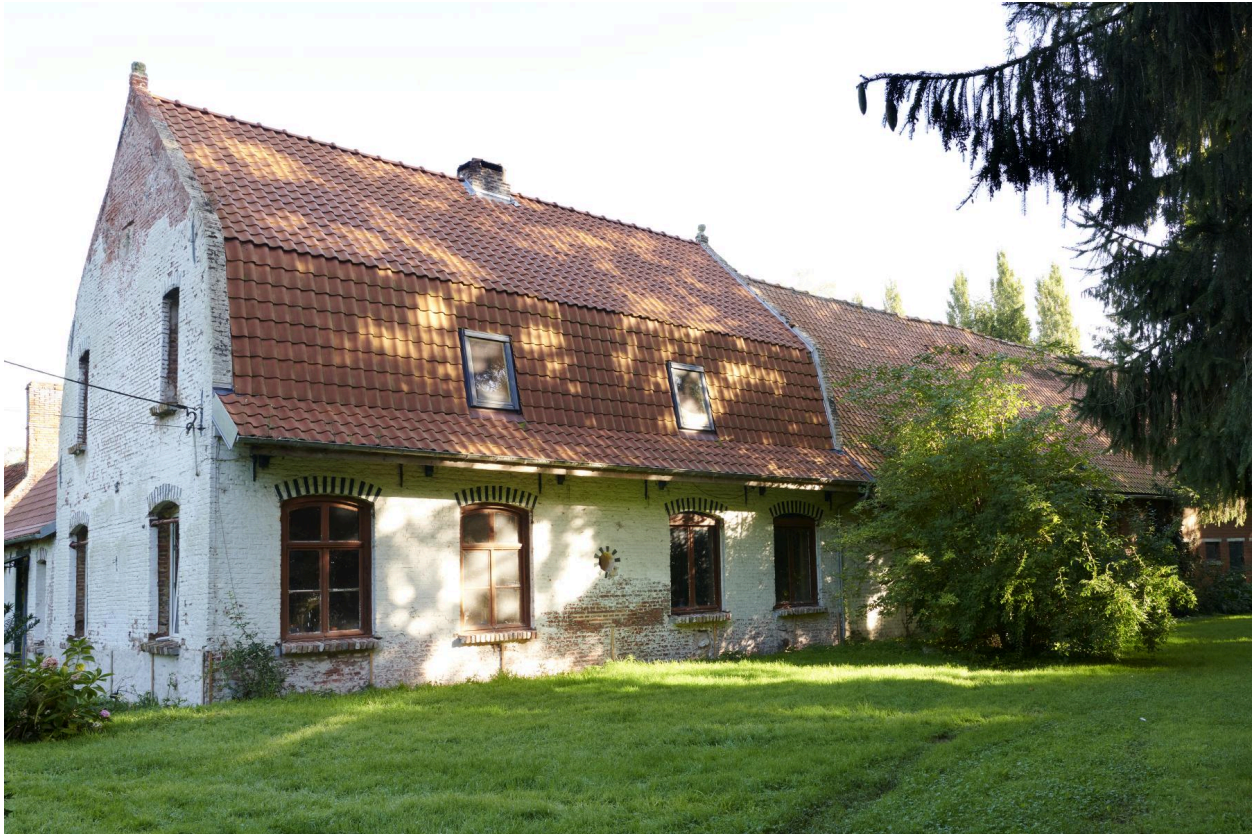
Façade sud et pignon ouest.
