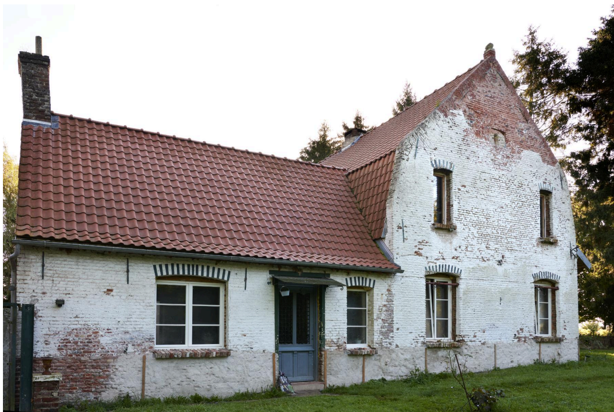
Vue d'ensemble de l'aile orientale.
