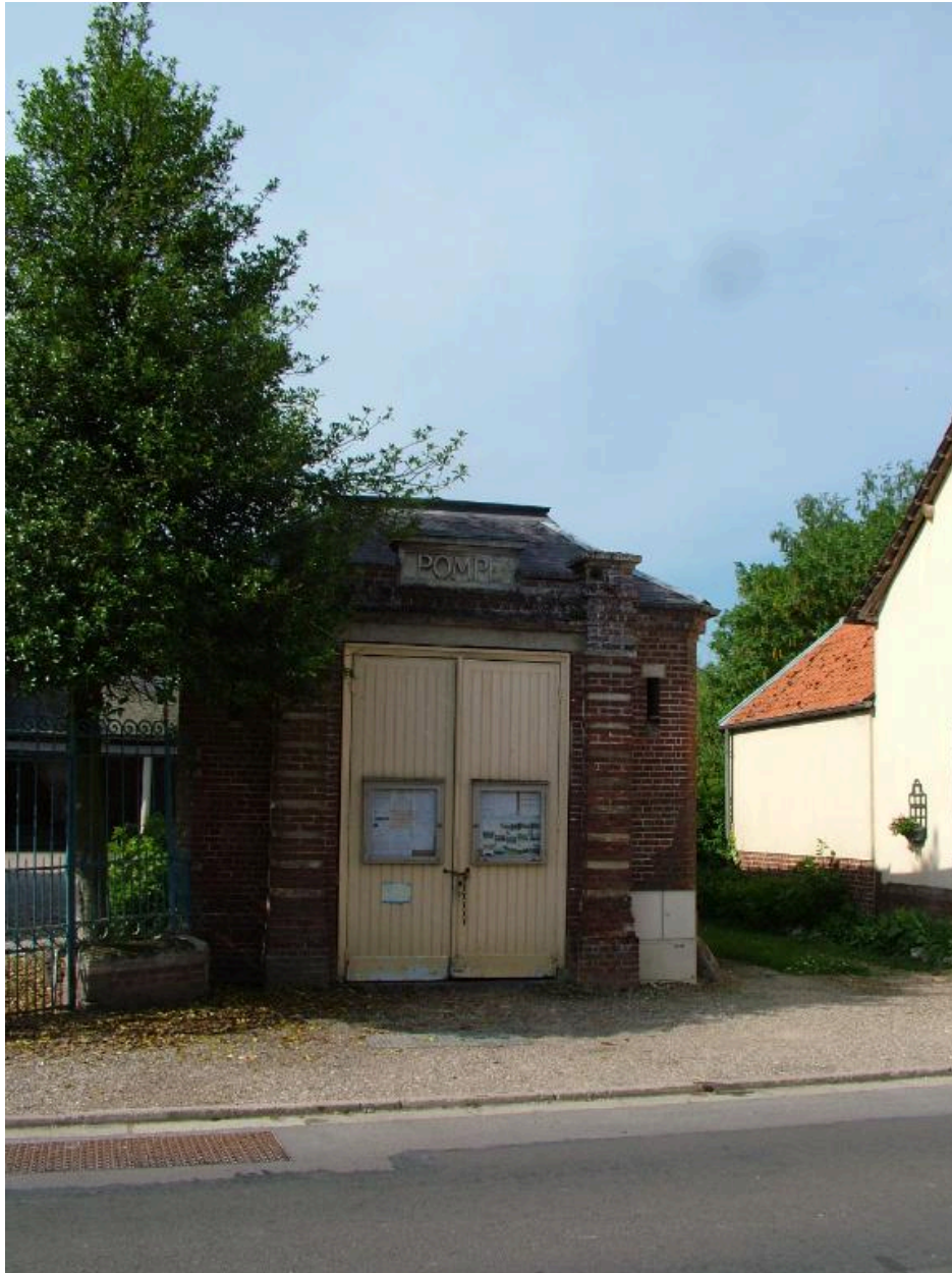
La remise de la pompe à incendie.
