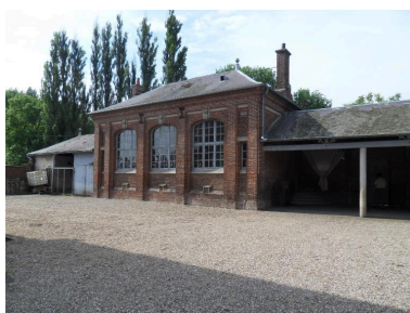
L'ancienne salle de classe. Phot. Isabelle Barbedor IVR22_20108010043NUCA
