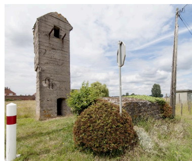
Vue générale des deux casemates, vers le nord-ouest Phot. Jean-Marc Ramette IVR32_20165901034NUCA
