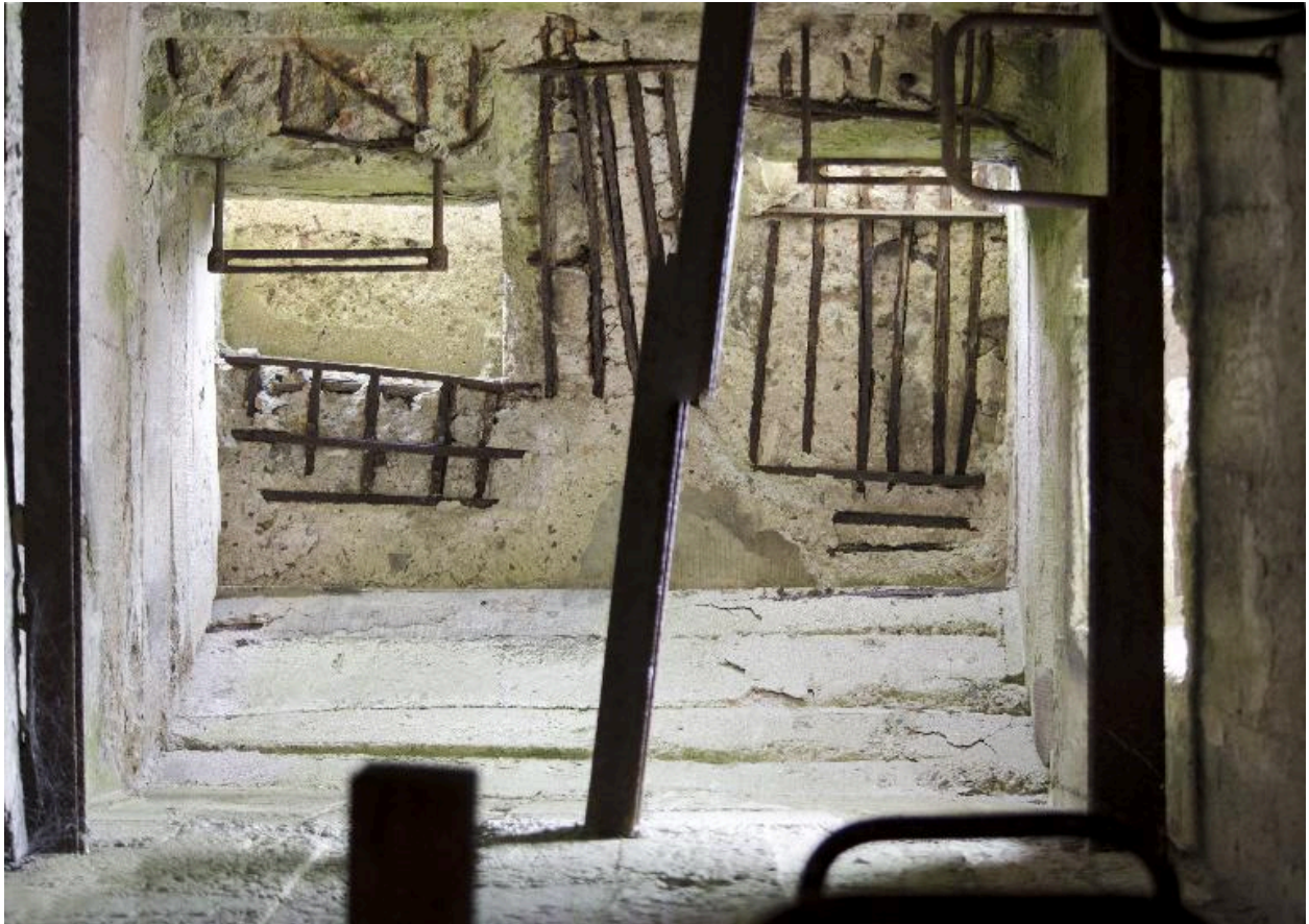
Intérieur de l'observatoire. Vue zénithale
