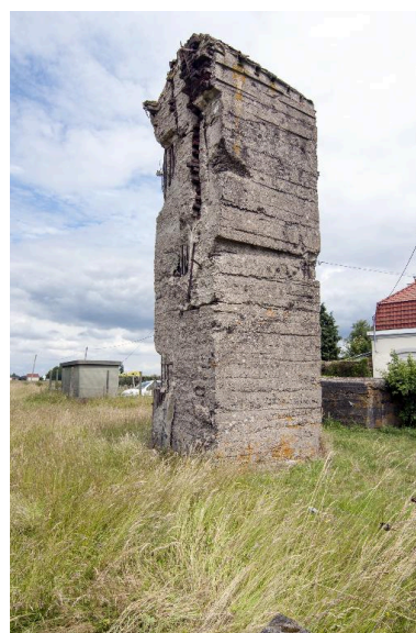
Vue de trois-quarts de l'observatoire vers le nord-est Phot. Jean-Marc Ramette IVR32_20165901037NUCA
