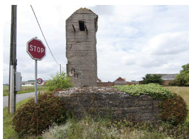
Vue générale des deux casemates, vers le nord-ouest Phot. Jean-Marc Ramette IVR32_20165901039NUCA
