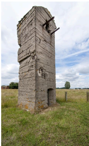
Vue de le l'observatoire, vers le nord-ouest Phot. Jean-Marc Ramette IVR32_20165901038NUCA
