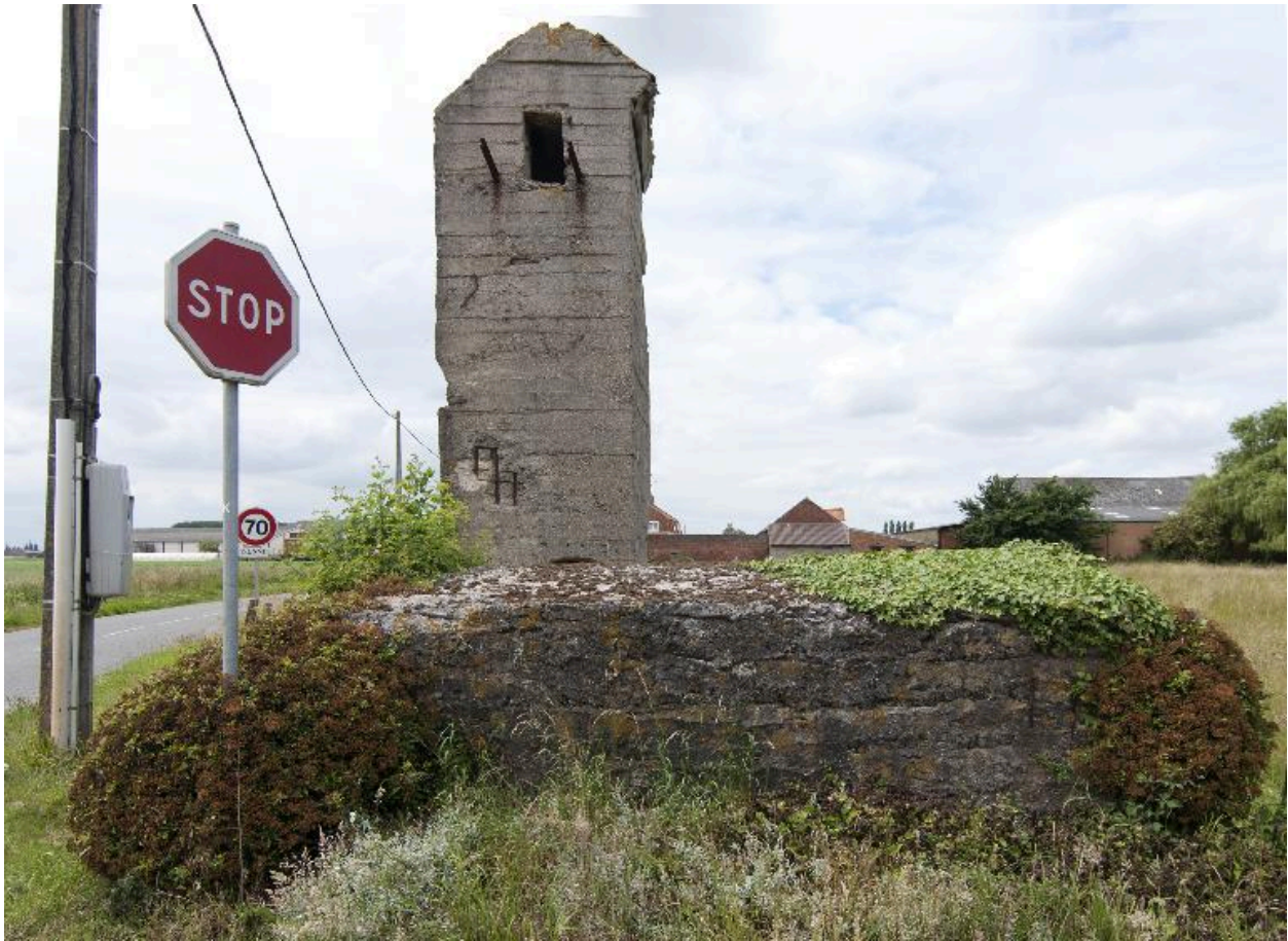
Vue générale des deux casemates, vers le nord-ouest
