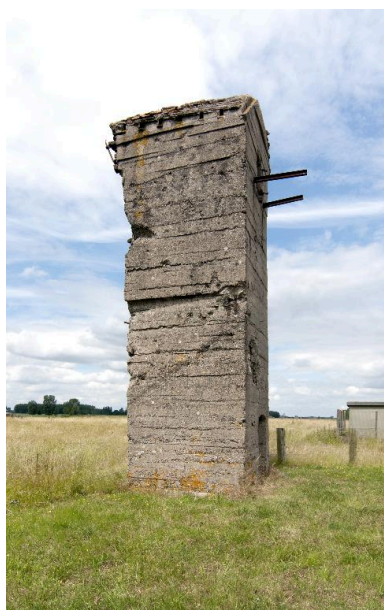
Vue de le l'observatoire, vers le nord Phot. Jean-Marc Ramette IVR32_20165901035NUCA
