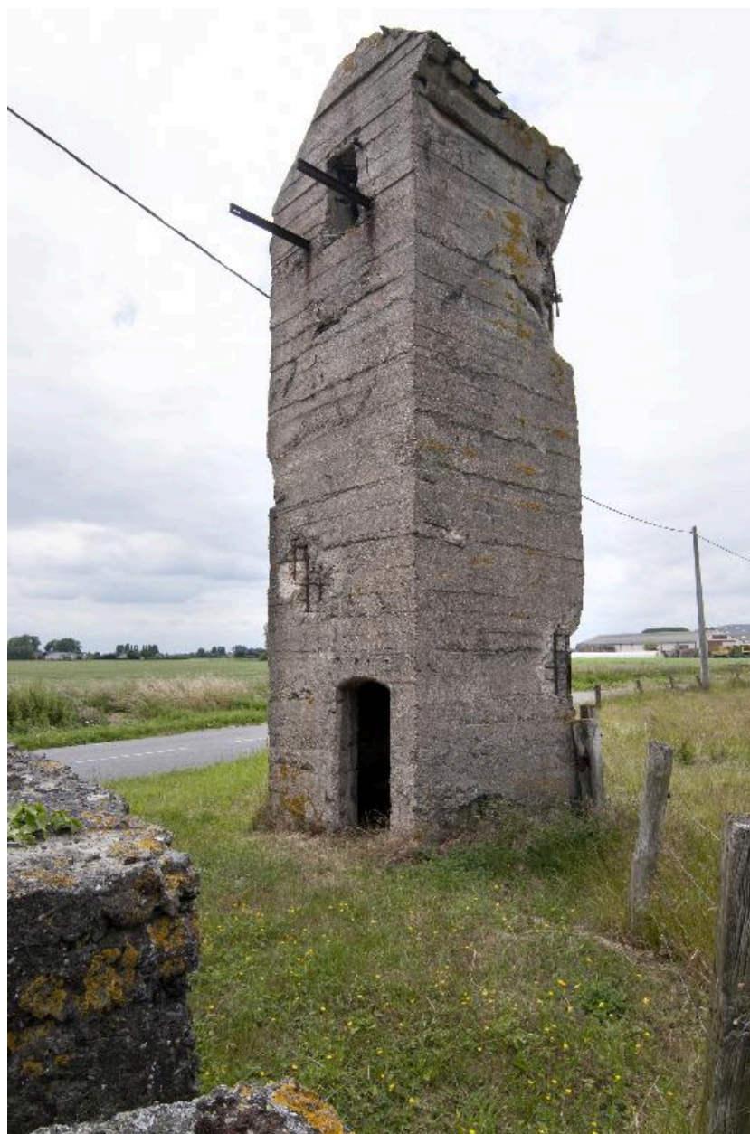
Vue de trois-quarts de l'observatoire, vers l'ouest
