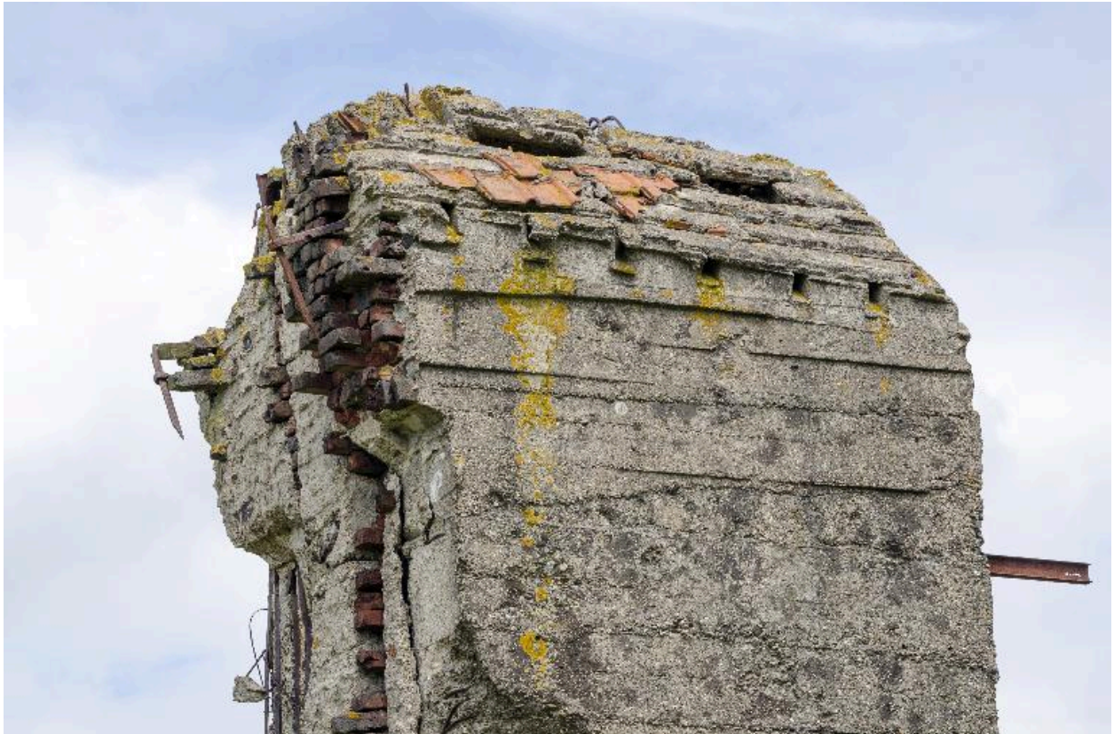
Couvrement de l'observatoire, vers l'est. On aperçoit les deux embrasures d'observation près du faîtage.
