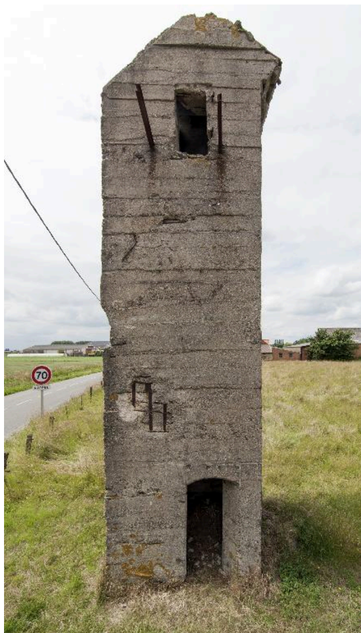
Vue frontale de l'observatoire vers le nord-ouest
