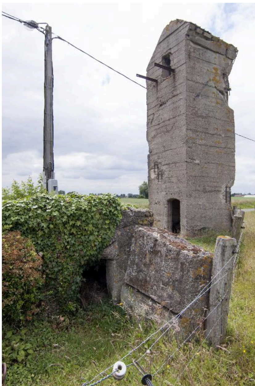
Vue générale des deux casemates, vers l'ouest
