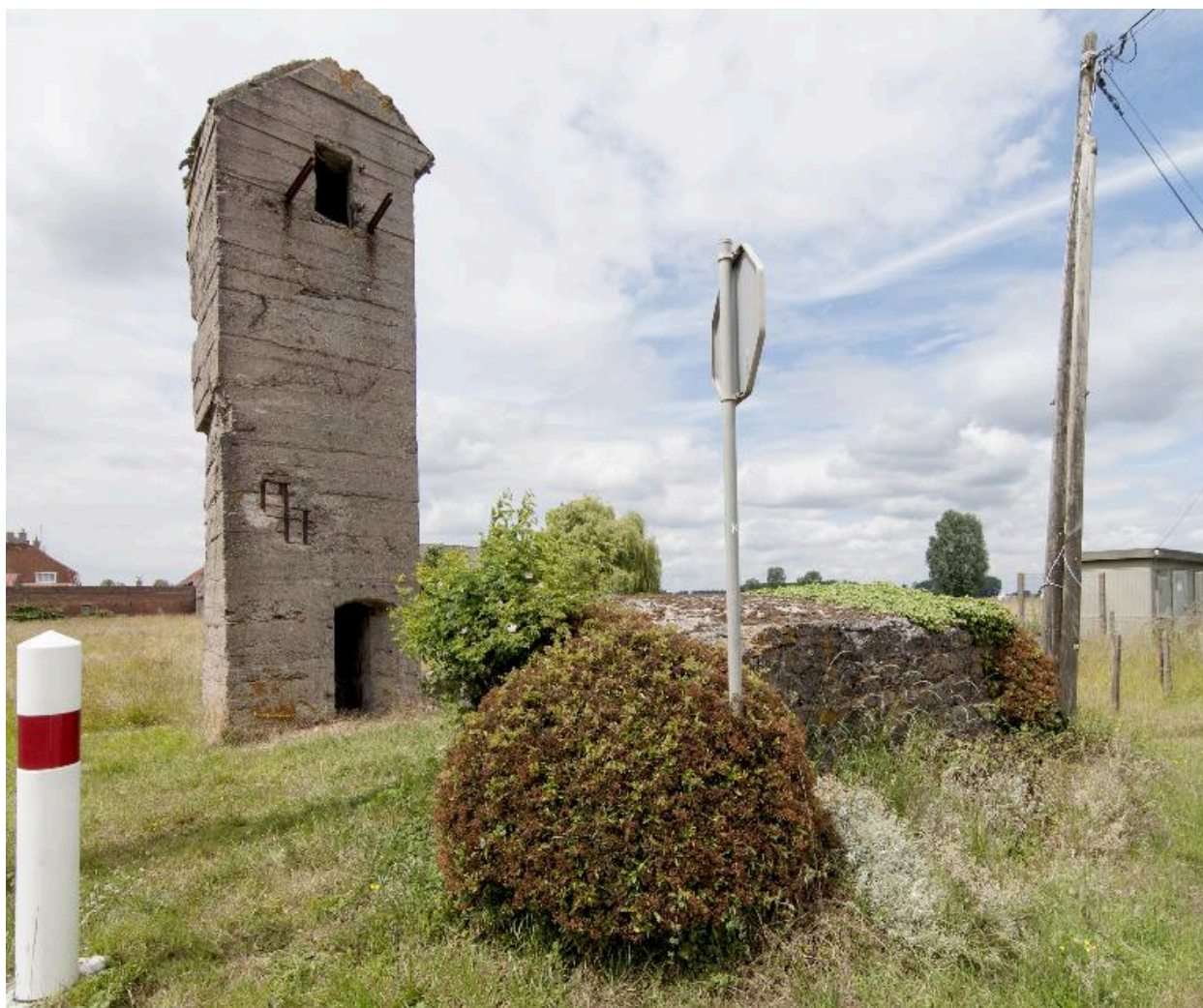
Vue générale des deux casemates, vers le nord-ouest
