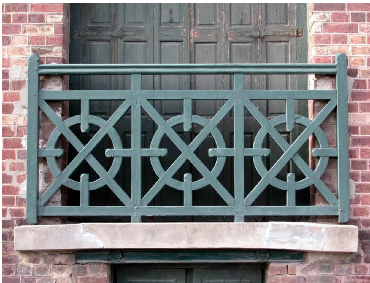
Détail du balconnet en menuiserie du rez-de-chaussée.
