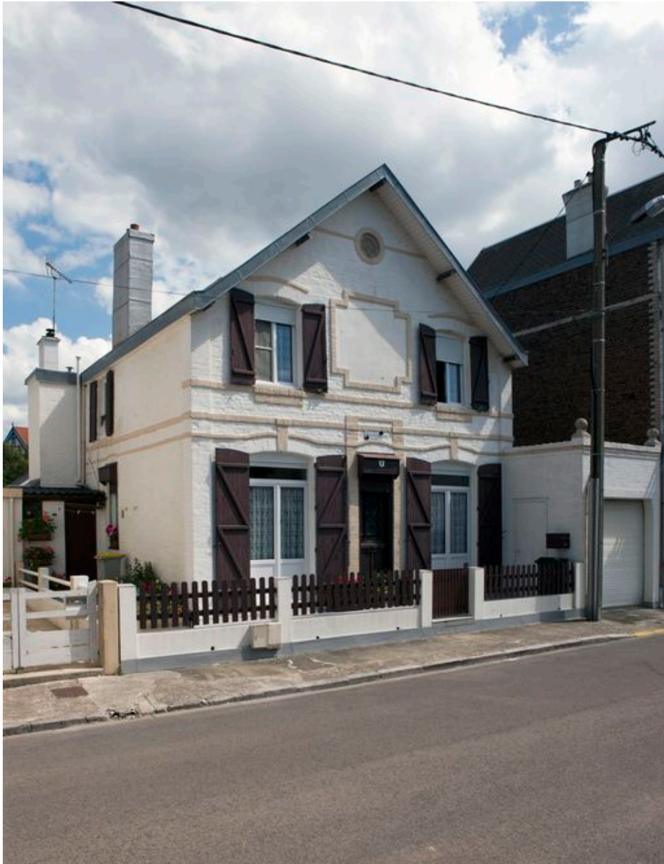
Façade du 3 rue Chambon.
