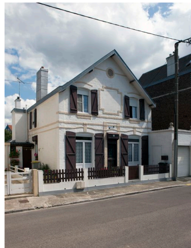
Façade du 3 rue Chambon.
