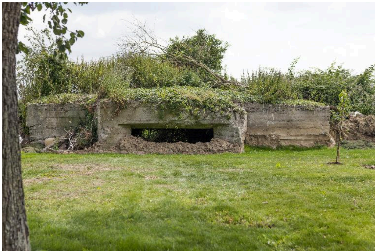
Vue frontale vers le sud-est
