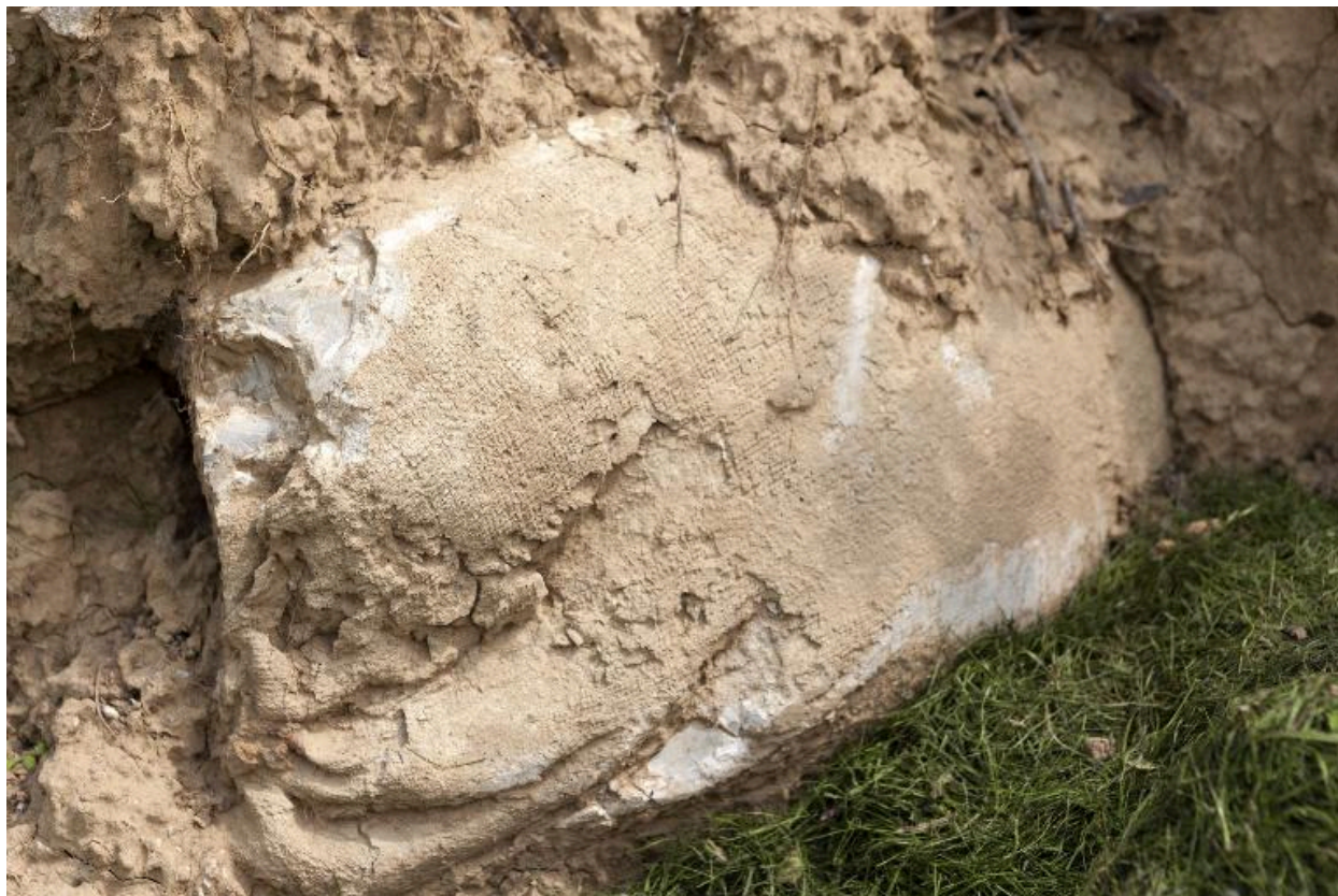
Sac de ciment, à la base de l'édifice. Utilisé couramment pour renforcer ou protéger une position
