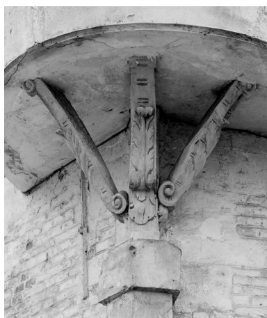
Détail des consoles de l'échauguette. Phot. Fabrice Charrondière IVR22_19856001385X
