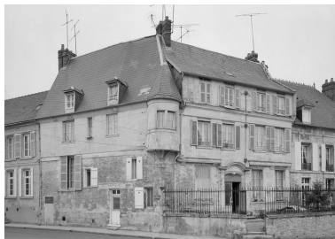
Elévation antérieure. Phot. Fabrice Charrondière IVR22_19856001388X
