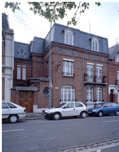
Vue générale. Phot. Pierre Thibaut IVR31_20086200191VA
