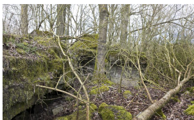
Elévation nord-est. Phot. Jean-Marc Ramette IVR31_20145904413NUCA
