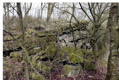
Elévation nord-est. Phot. Jean-Marc Ramette IVR31_20145904414NUCA
