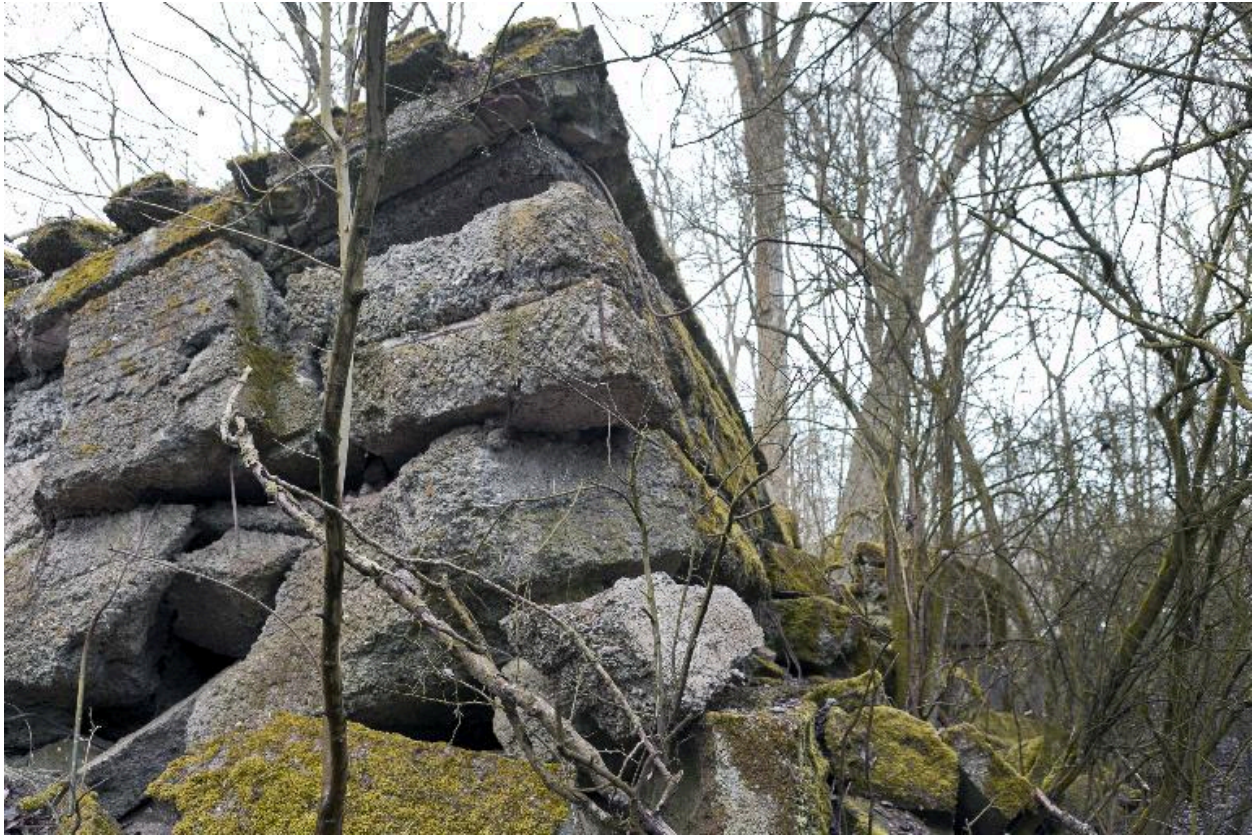
Elévation nord-est. Détail de la structure du béton armé
