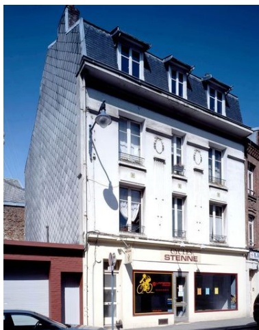
Vue générale. Phot. Pierre Thibaut IVR31_20086200222VA
