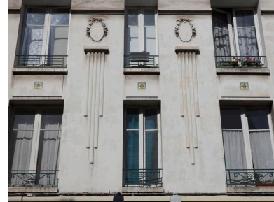
Guirlandes aux formes tubulaires, surmontées de médaillons ornés de fleurs. Phot. Pierre Thibaut IVR31_20096200208NUCA
