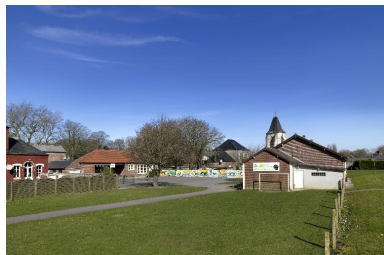
Vue de situation. Phot. Thierry Lefébure IVR22_20158000104NUC2A
