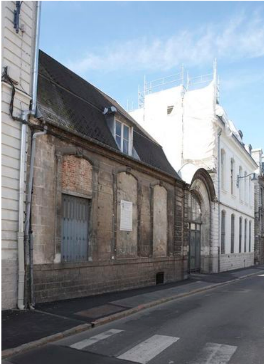
Vue générale. Hôtel en restauration
