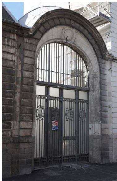
Porte cochère. Phot. Pierre Thibaut IVR31_20086200318NUCA
