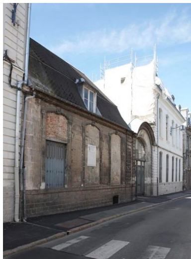
Vue générale. Hôtel en restauration Phot. Pierre Thibaut IVR31_20096200185NUCA
