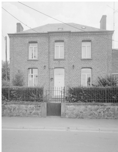
Vue du logis. Phot. Pierre Thibaut IVR31_20055904662V
