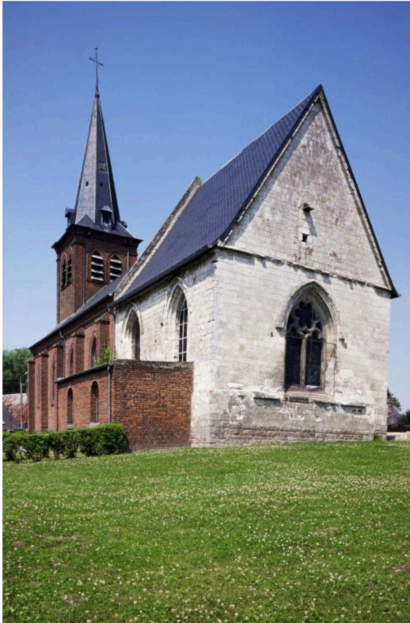
Vue du chevet et du flanc sud de l'église.
