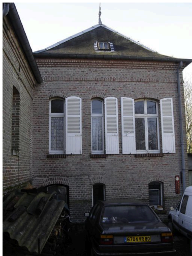
Vue postérieure depuis la ruelle Ladera. Phot. Inès Guérin IVR22_20058005289NUCA
