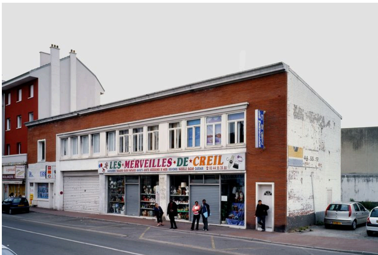
Vue générale de l'ancienne usine de construction mécanique Gueudet.
