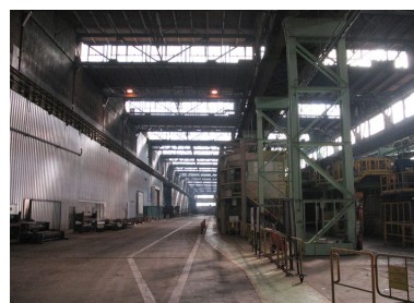
Ligne de décapage (à l'arrêt).
