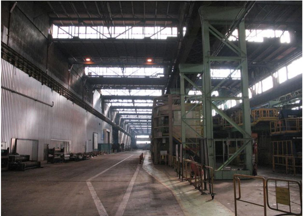
Ligne de décapage (à l'arrêt).
