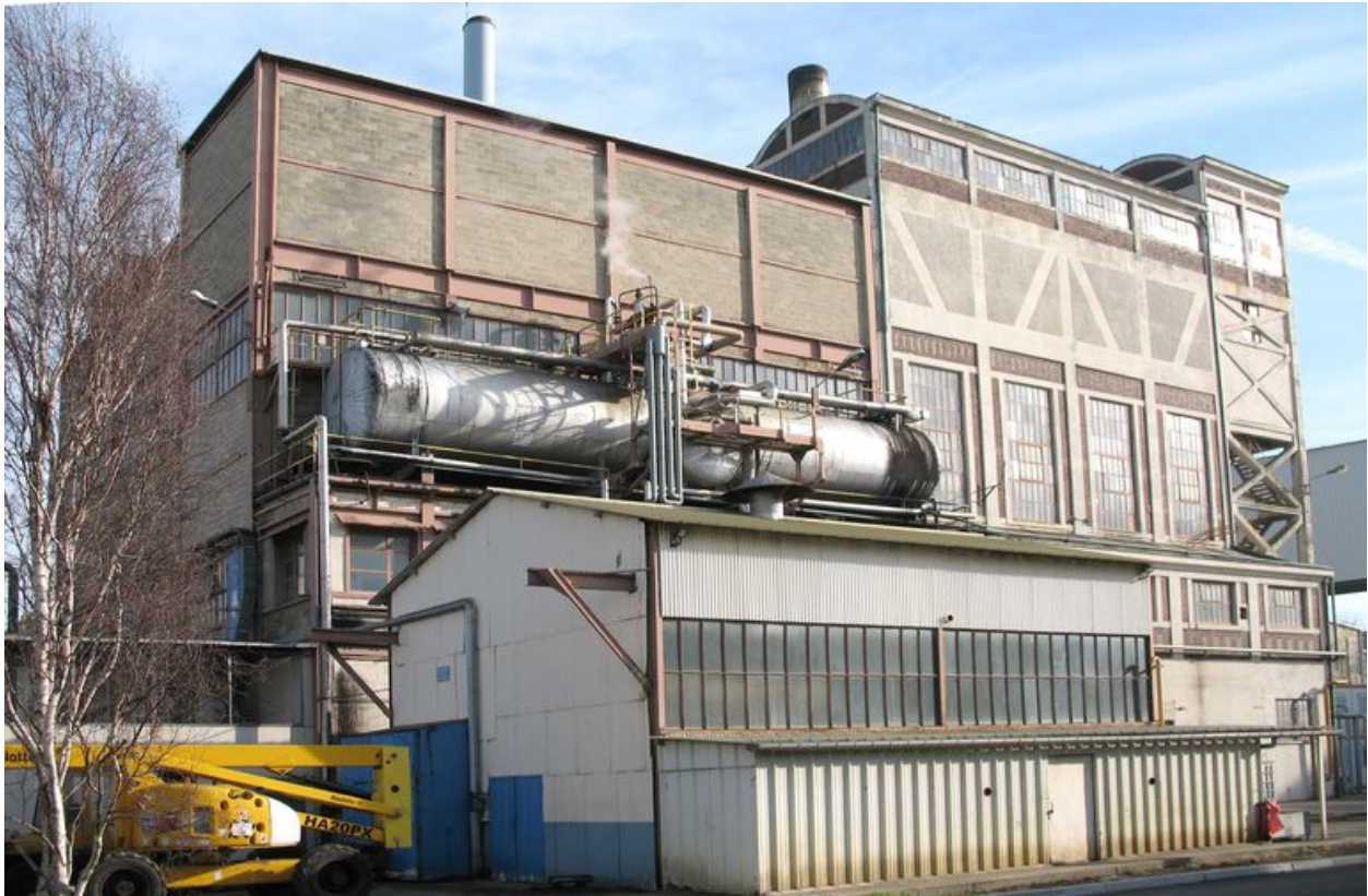
Elévation ouest de la centrale vapeur.
