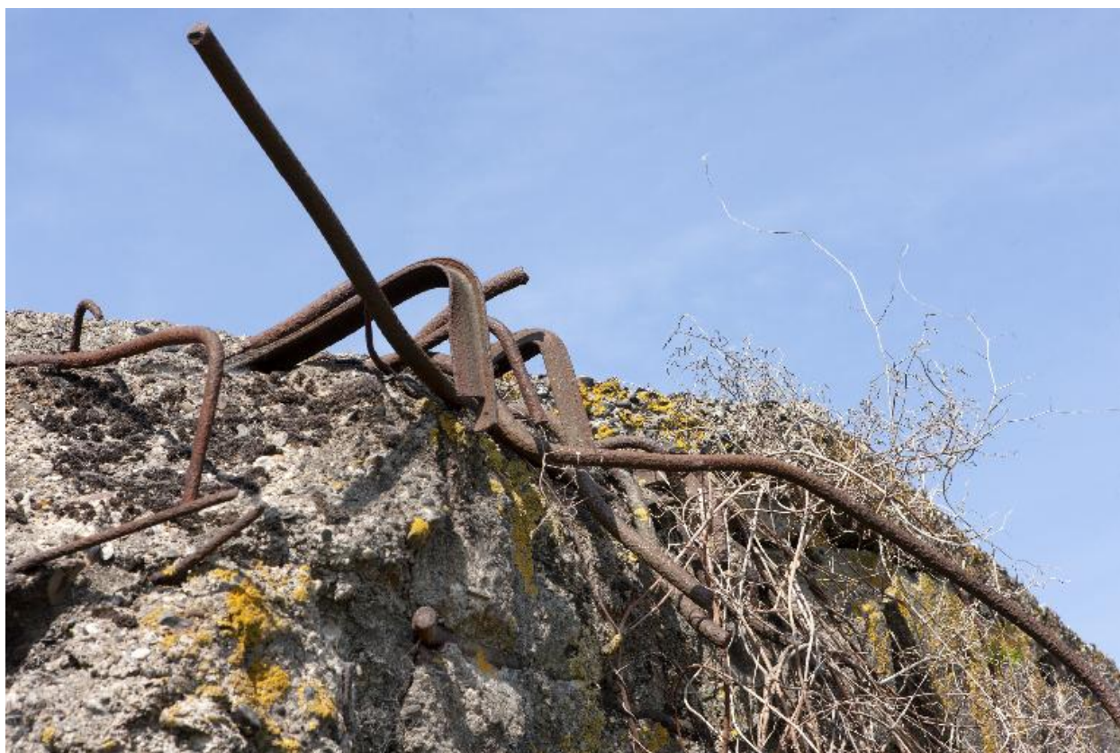
Partie est, détail du béton et des fers. Trois fers différents sont ici visibles.
