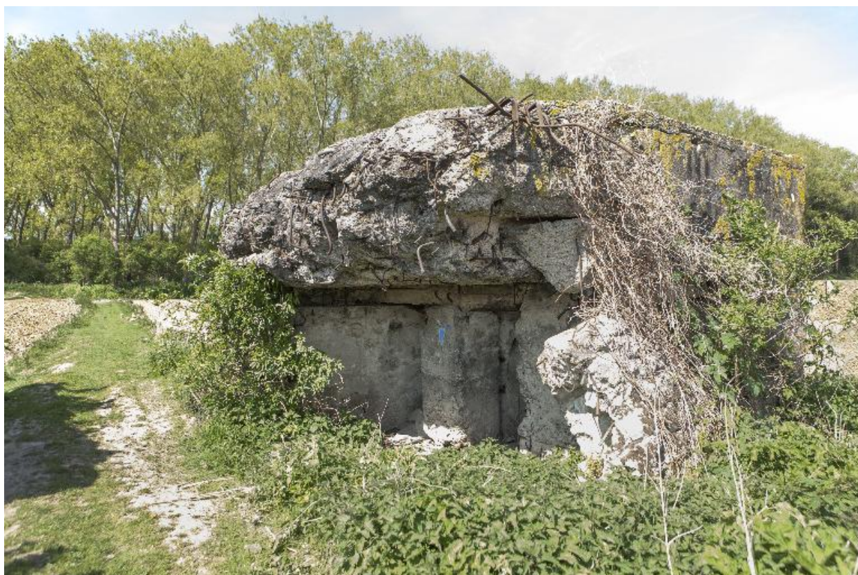
Partie est, vers le nord
