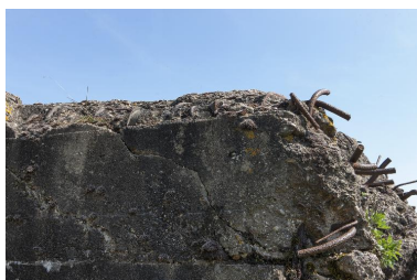
Partie est, détail du béton et des fers Phot. Jean-Marc Ramette IVR31_20145904859NUCA
