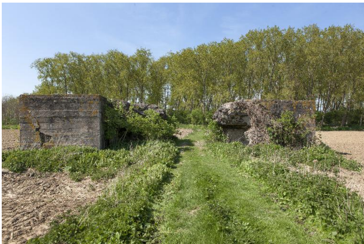
Vue générale vers le nord-ouest
