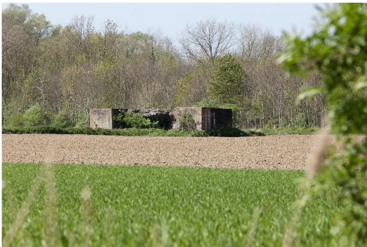
Vue générale vers le nord-est
