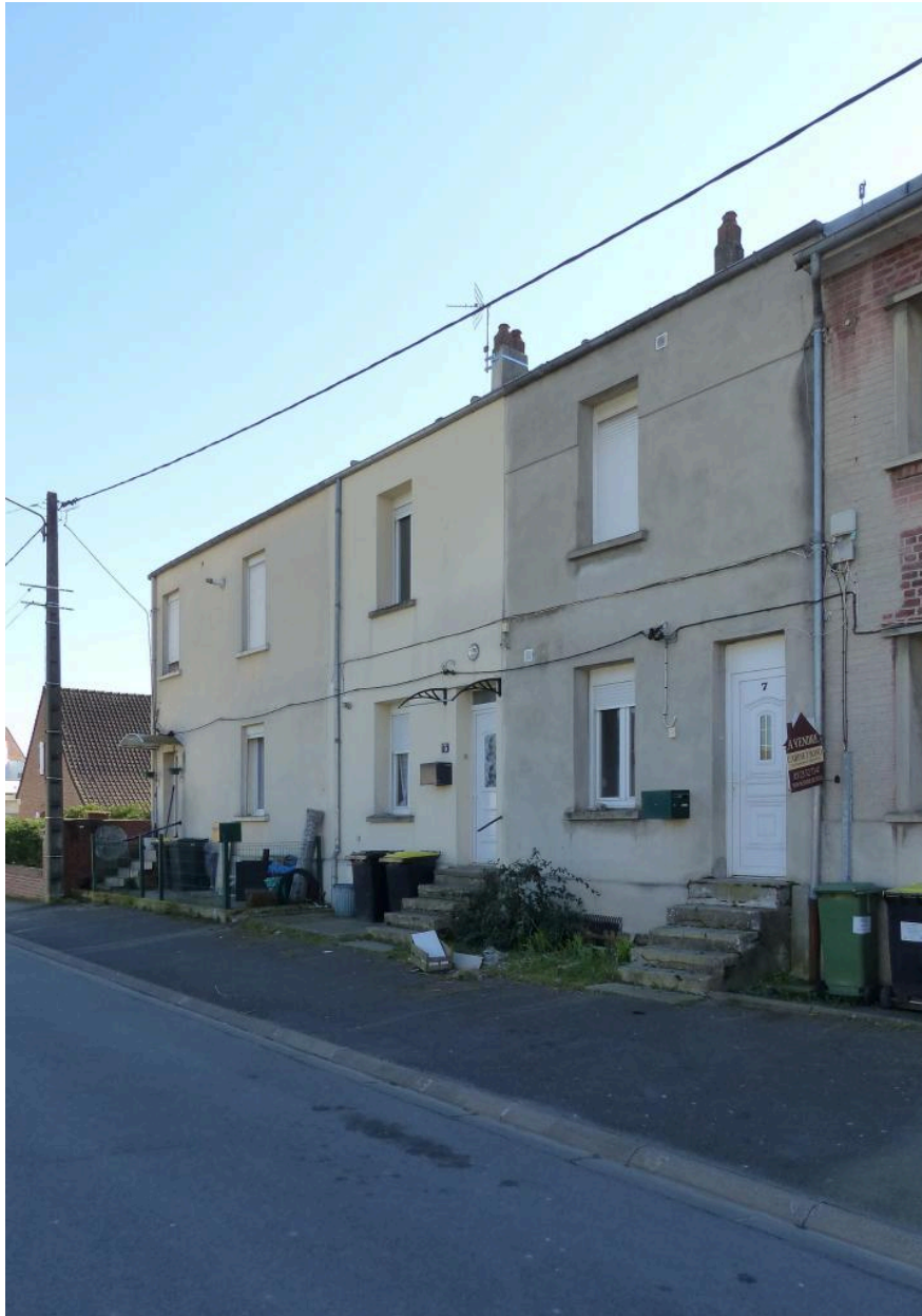
Les logements d'origine remaniés.
