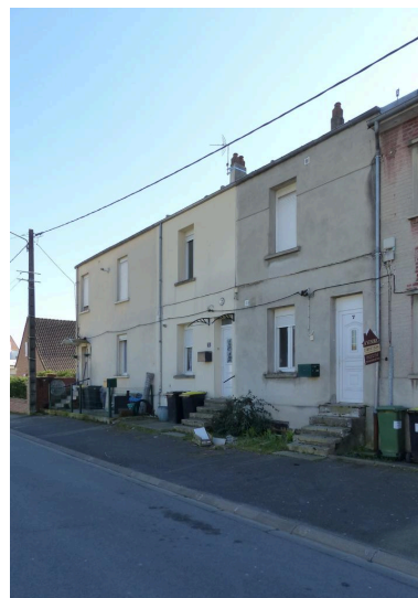
Les logements d'origine remaniés. Phot. Isabelle Barbedor IVR32_20220205063NUCA
