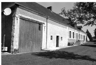
Vue générale. Phot. Xavier-Philippe Guiochon IVR22_19980202725Z
