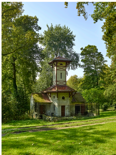
Vue du pigeonnier. Phot. Thierry Lefébure IVR32_20248001419NUCA
