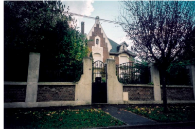
Portail et grille. Phot. Gilles-Henri Bailly IVR22_20158005481NUCA
