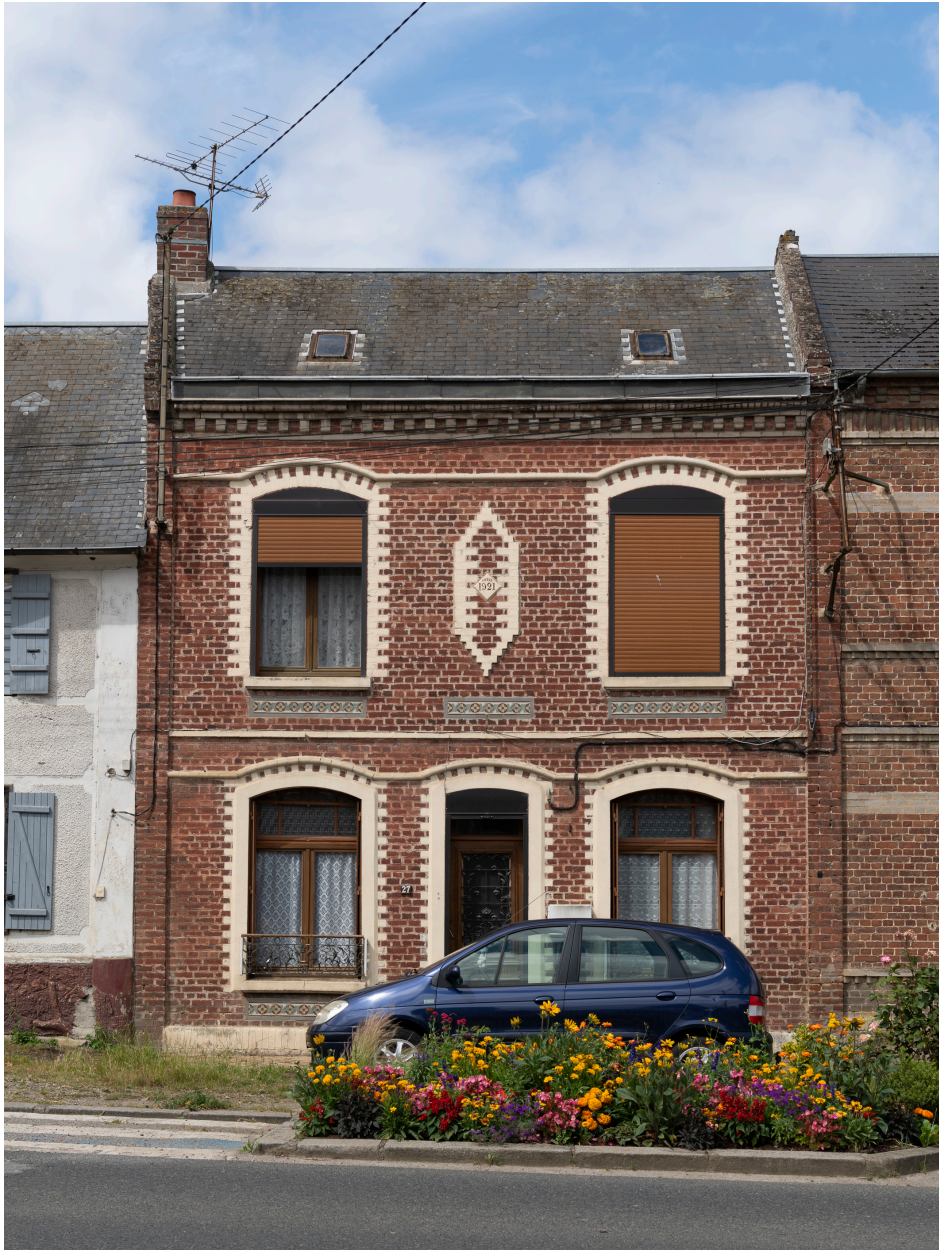
Logis de l'ancien patron de l'usine Dodé-Sellier, n°27 de la Grande Rue, vue depuis l'est.
