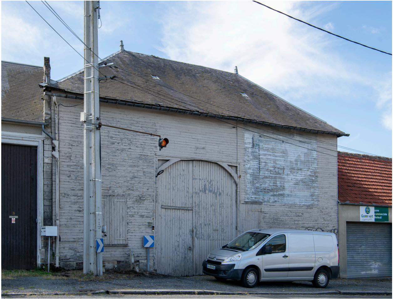
Grange sur rue essentée en bois, n°4 de la rue de la Commanderie, vue depuis le nord.
