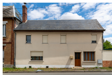
Ancien café Pillon, n°1bis de la rue Saint-Antoine, vue depuis l'ouest. Phot. Marc Kérignard IVR32_20246000728NUCA
