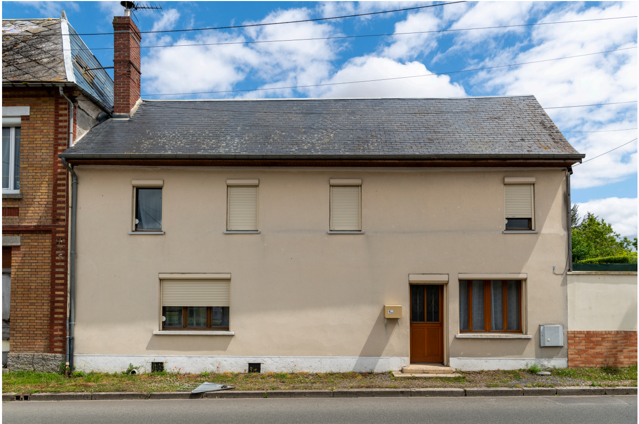
Ancien café Pillon, n° 1bis de la rue Saint-Antoine, vue depuis l'ouest.
