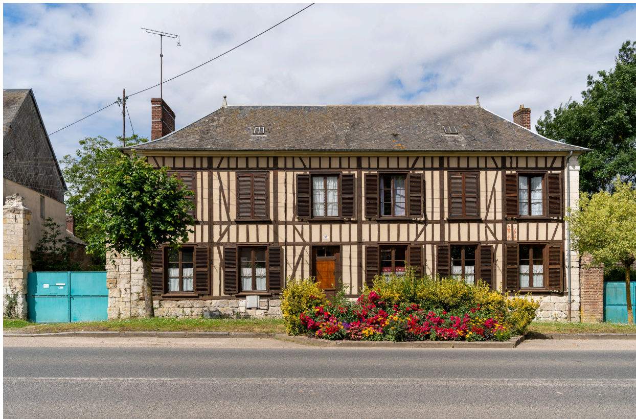
Logis de ferme, n°37 de la Grande Rue, vue depuis l'est.
