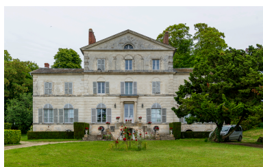
Demeure dite "Petit Château", n°5 de la Grande Rue, vue depuis l'ouest. Phot. Marc Kérignard IVR32_20246000669NUCA
