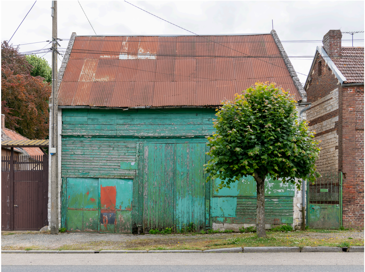
Grange sur rue essentée de bois, n°8 de la Grande Rue, vue depuis l'ouest.
