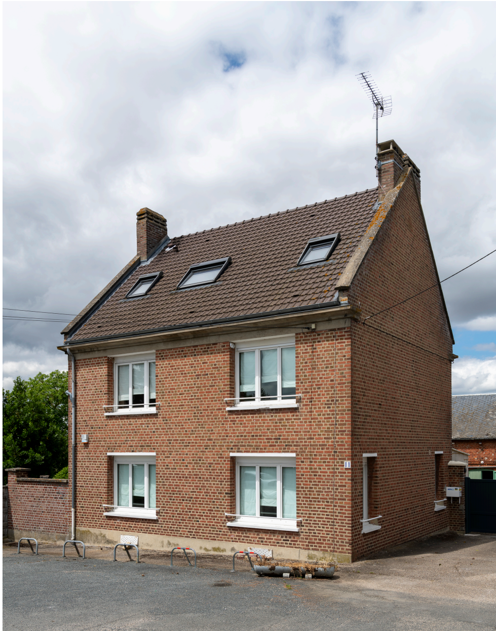
Logis de l'ancienne ferme reconstruite après sa destruction en 1940, n°11 de la rue des Aires, vue depuis le sud.
