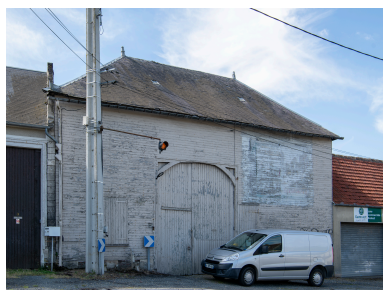
Grange sur rue essentée en bois, n°4 de la rue de la Commanderie, vue depuis le nord. Phot. Marc Kérignard IVR32_20246000740NUCA
