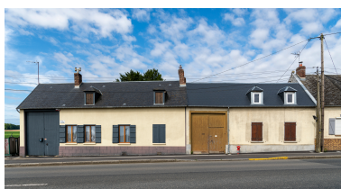
Deux logis sur rue avec entrée charretière, n°19 et 20 de la rue Saint-Antoine, vue depuis l'est. Phot. Marc Kérignard IVR32_20246000739NUCA
