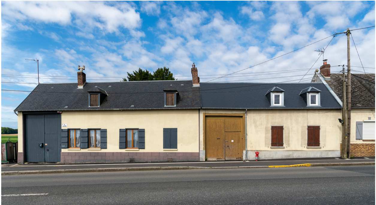
Deux logis sur rue avec entrée charretière, n°19 et 20 de la rue Saint-Antoine, vue depuis l'est.
