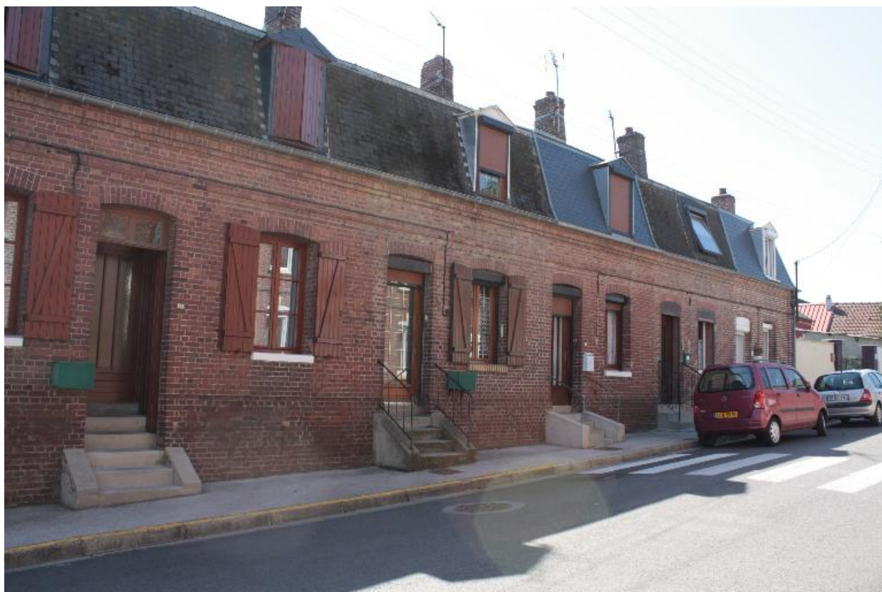
Les maisons ouvrières, rue Ambroise-Croizat.
