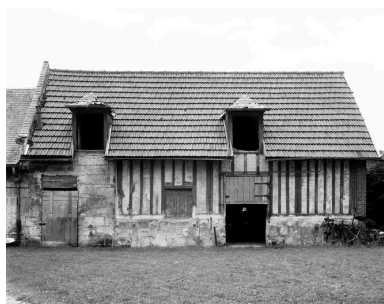
Etable. Elévation antérieure. Phot. Jean-Michel Perrin IVR22_19846001167V
