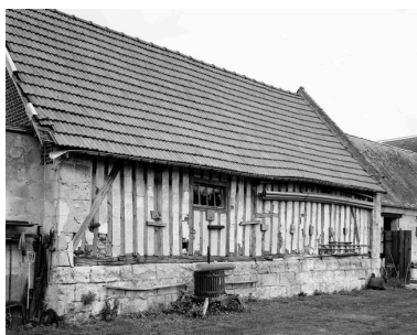
Etable. Elévation postérieure. Phot. Jean-Michel Perrin IVR22_19846001168V
