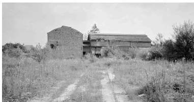
Vue de situation. Phot. Benoît Dufournier IVR22_19936001612Z
