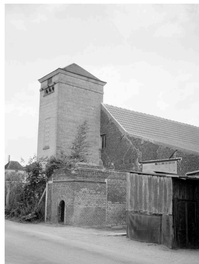
Transformateur électrique. Phot. Benoît Dufournier
