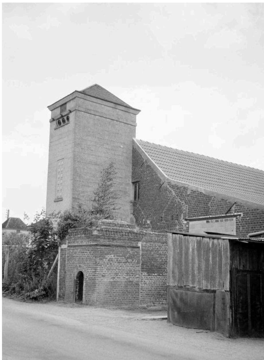
Transformateur électrique.
