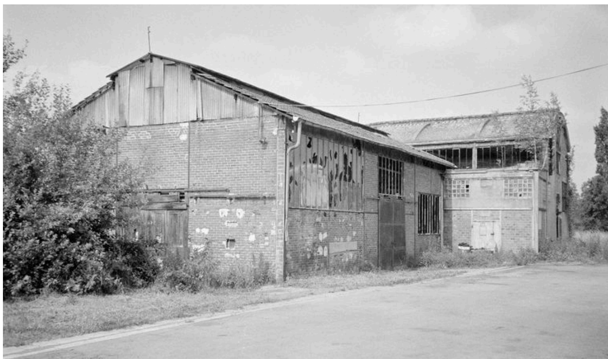
Atelier de fabrication.
