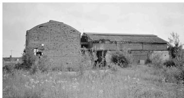
Vue générale. Phot. Benoît Dufournier IVR22_19936001611Z
