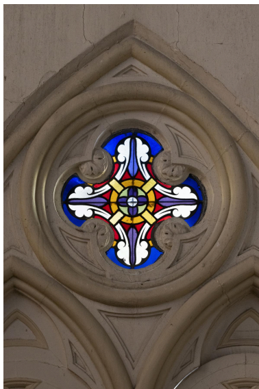
Détail de la partie verrière située dans la partie basse du mur nord est du chœur. Phot. Pierre Thibaut IVR32_20265900656NUCA
