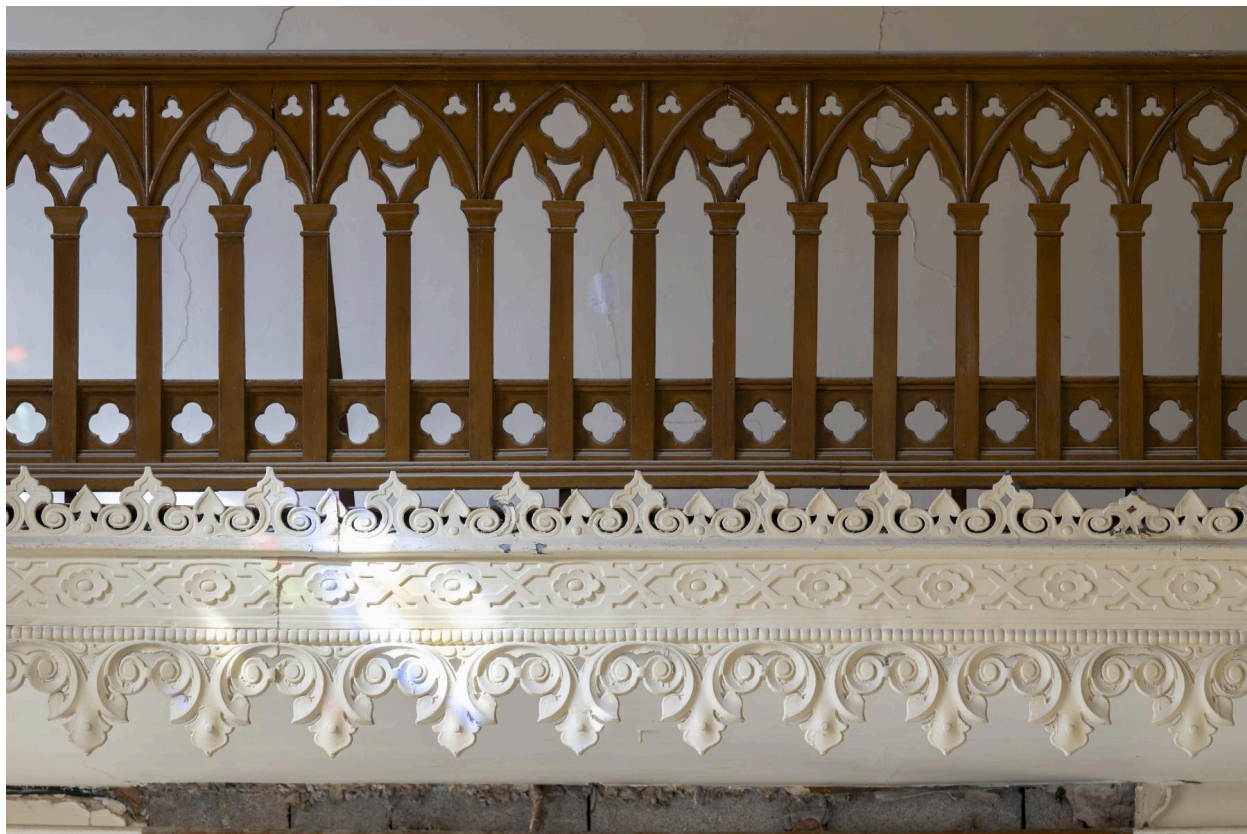
Vue de détail de la clôture de la tribune avec son lambrequin.
