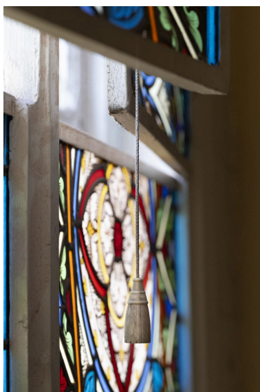
Détail du cordon et de sa pampille en plâtre imitant les pampilles en fil qui permet de contrôler l'ouverture des deux parties de l'imposte. Phot. Pierre Thibaut IVR32_20265900664NUCA
