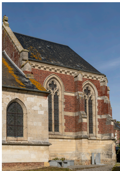
Chevet, vue prise depuis le sud. Phot. Marc Kérignard IVR32_20236001109NUCA
