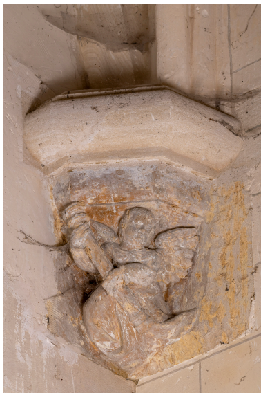
Culot de voûte de la première travée du chœur : angelot portant une colonne. Phot. Marc Kérignard IVR32_20236001086NUCA
