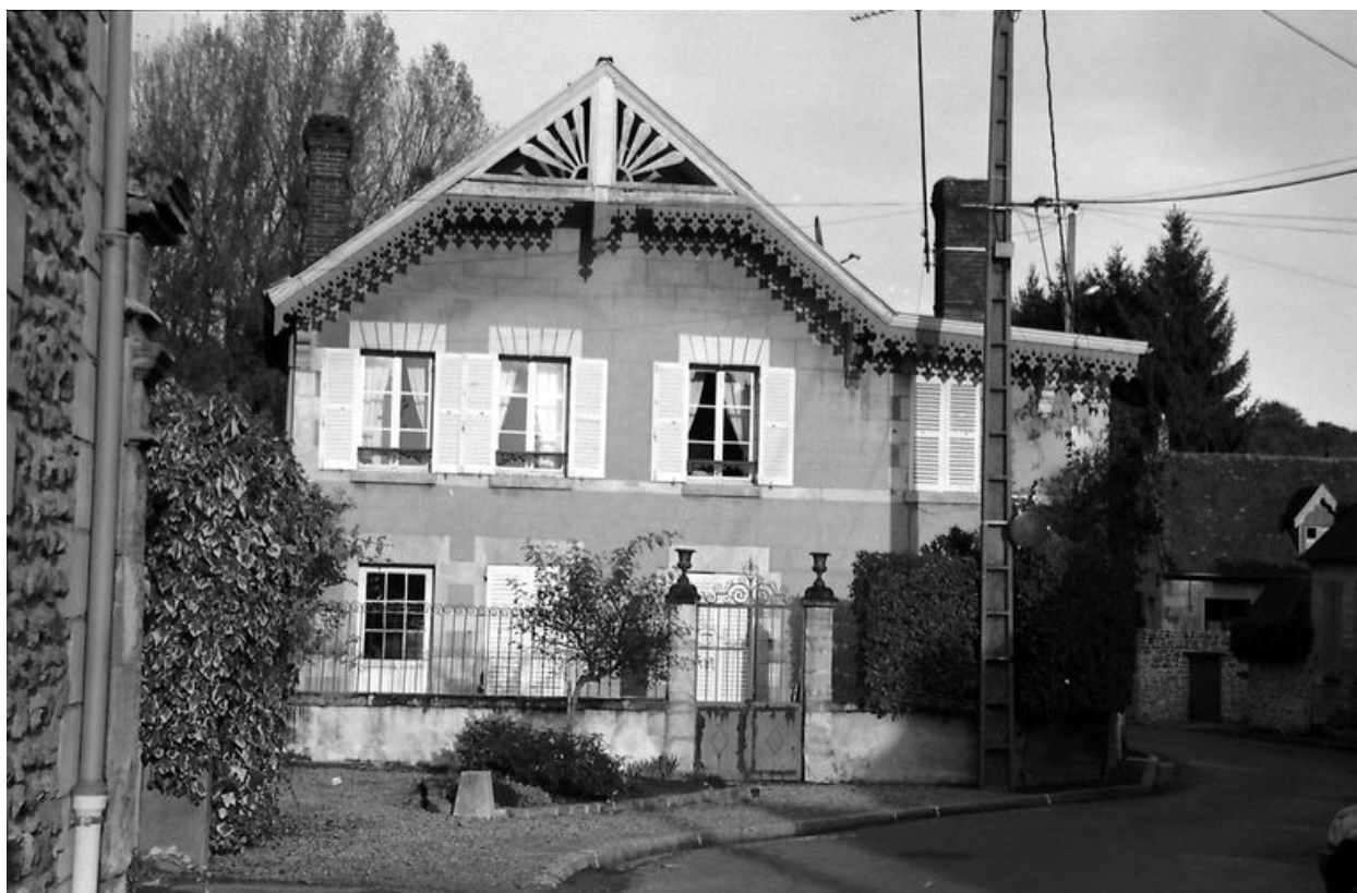
Maison patronale, façade sur rue.
