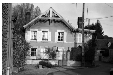
Maison patronale, façade sur rue. Phot. Bertrand Fournier IVR22_20006000833Z
