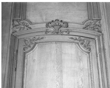
Porte n° 1, linteau : détail. Phot. Jean-Michel Périn IVR31_19886200500X
