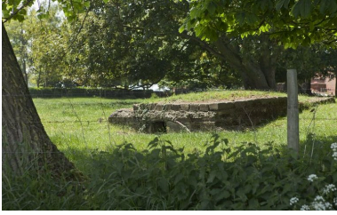
Vue générale, vers l'ouest Phot. Jean-Marc Ramette IVR31_20145904095NUCA
