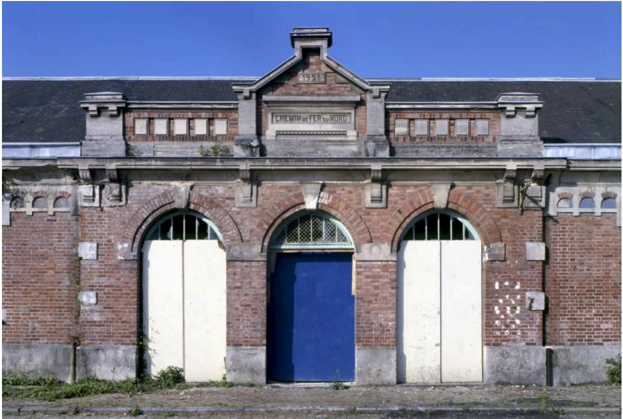
Détail de la travée centrale de la façade, sur la place portant la date de 1921.
