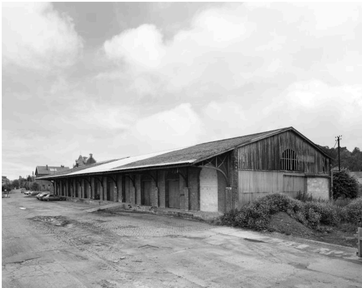
Vue de la halle de chargement.
