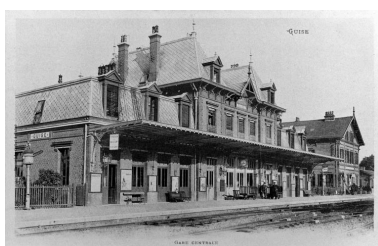
Vue de la façade sur les quais. Carte postale, début du 20e siècle. Phot. Christiane Riboulleau IVR22_19990201547ZB
