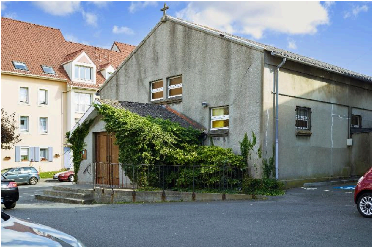
Élévation générale l'église.
