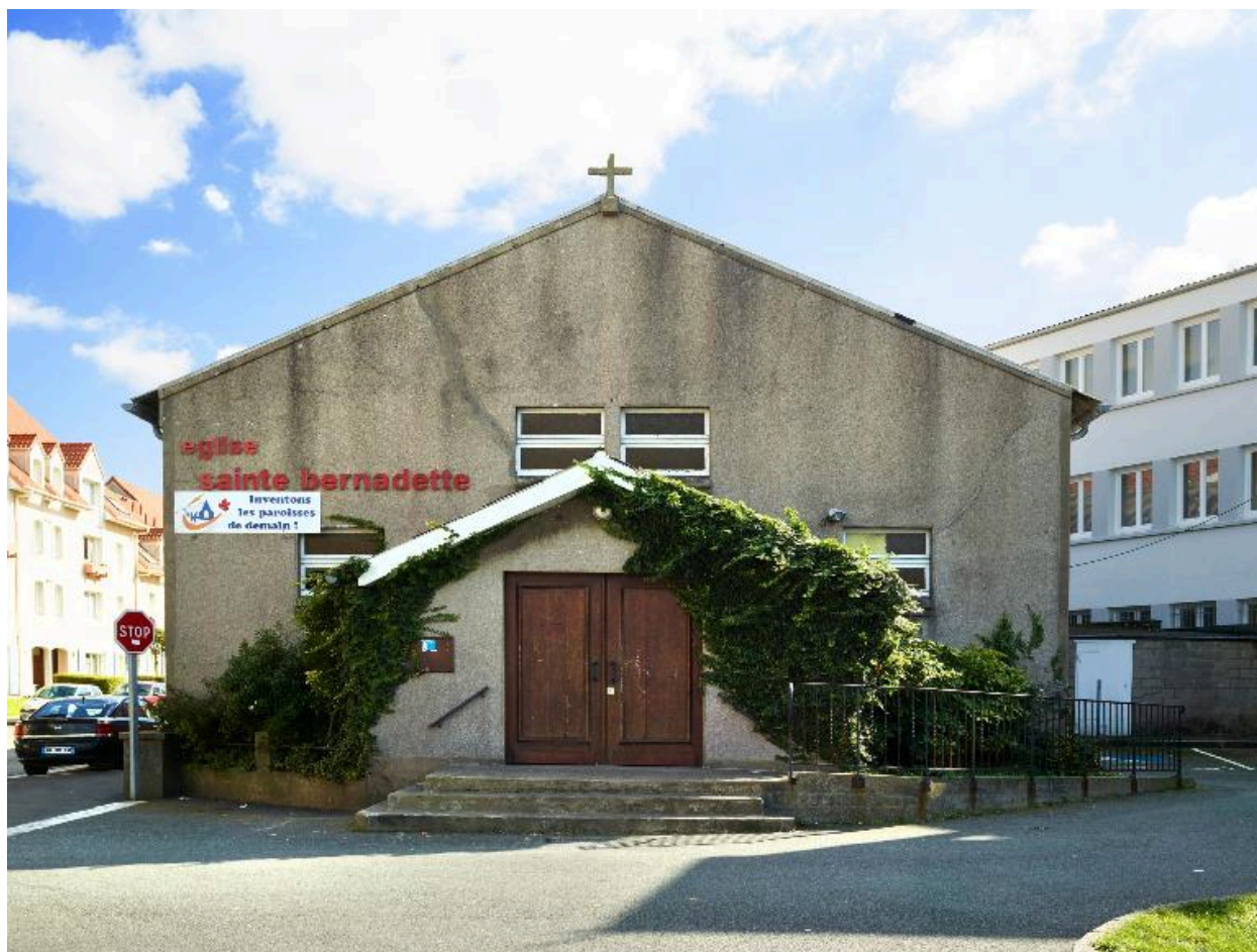
Élévation générale l'église.
