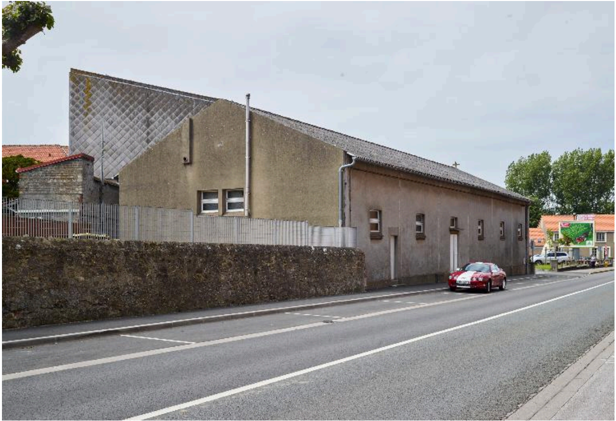
Élévation générale l'église.
