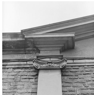
Façade sur voie, chapiteau : détail.
