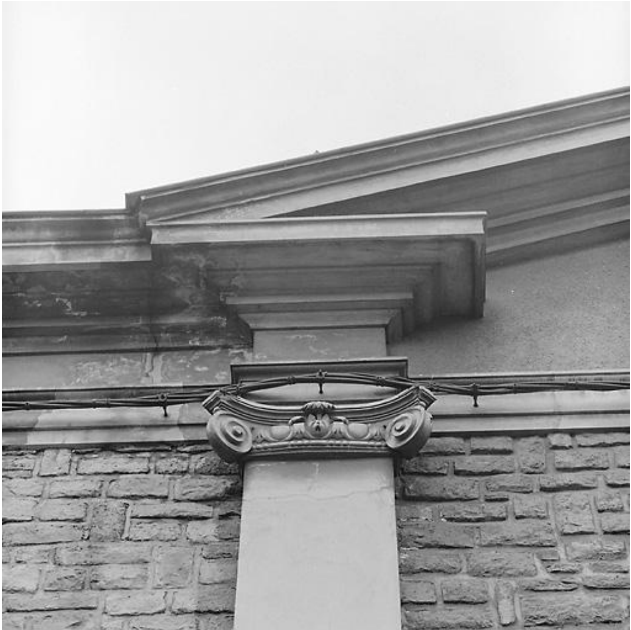
Façade sur voie, chapiteau : détail.
