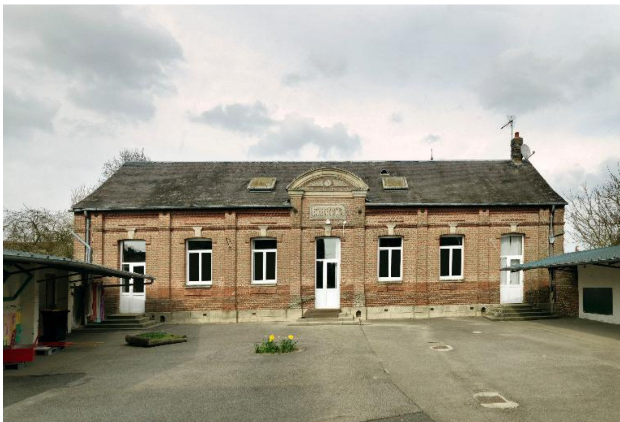
Façade sur cour de la salle de classe.
