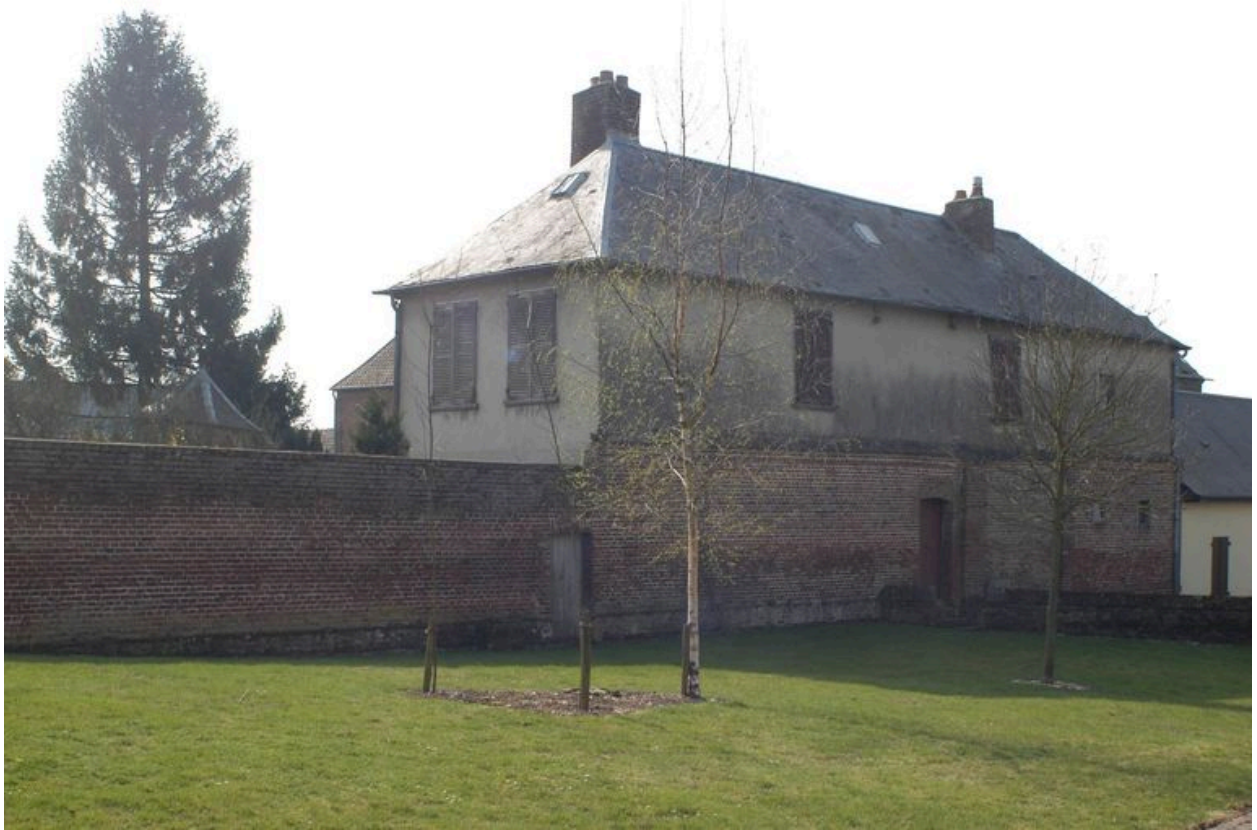
Façade postérieure ouest.
