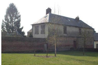
Façade postérieure ouest. Phot. Thierry Lefébure IVR22_20038000262NUCA
