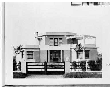
Vue frontale, entre 1927 et 1934, Danis architecte, in Travaux d'Architecture (AP Dieux). Repro. Olivier Marlard IVR31_19925901797X
