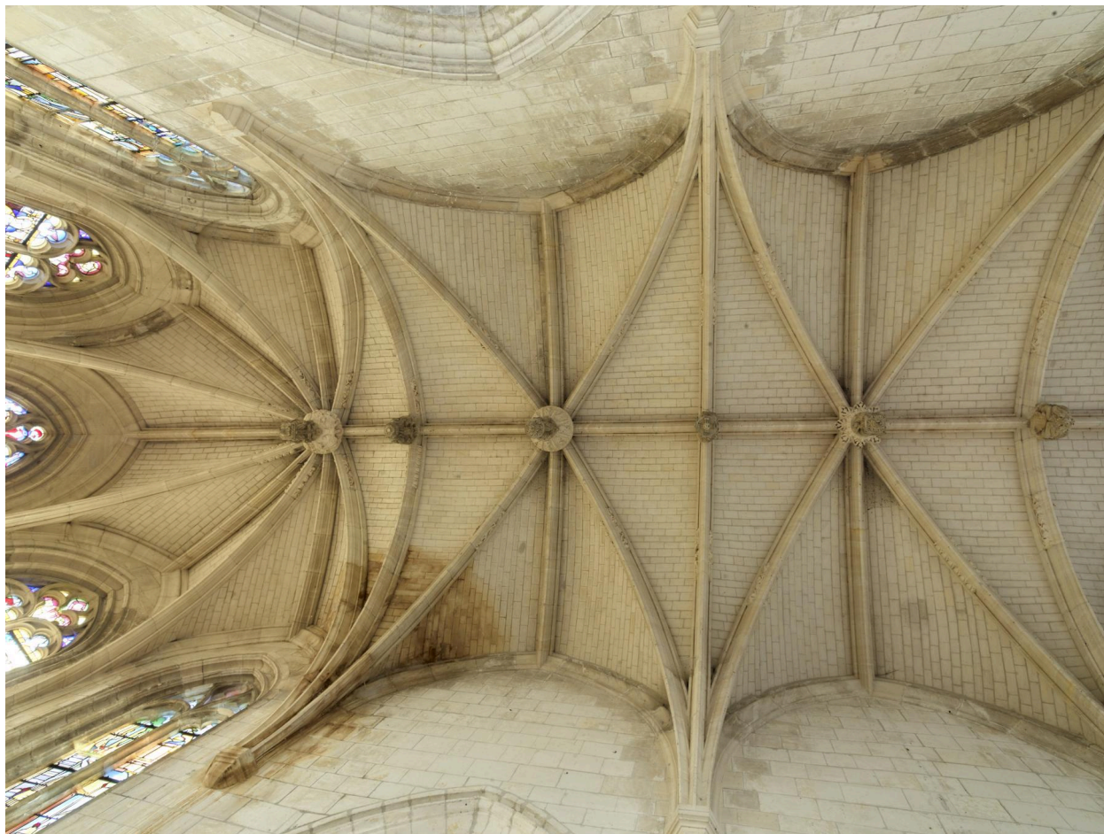
Voûte du chœur, vue d'ensemble.
