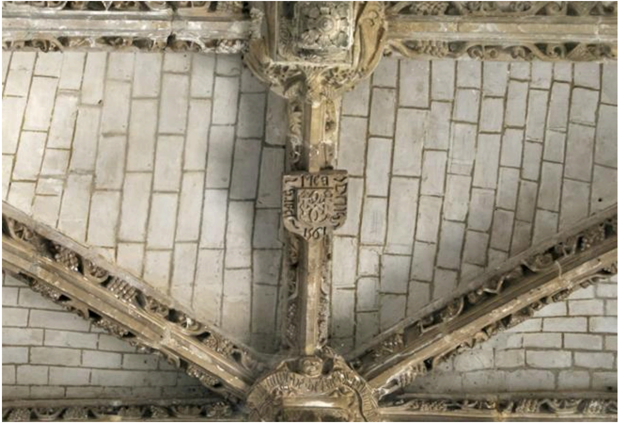
Date de 1561 gravée sur une des clefs de voûte de la chapelle de la Vierge.
