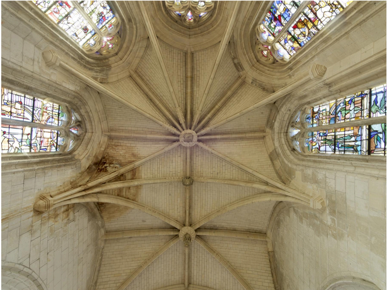
Voûte du chœur.
