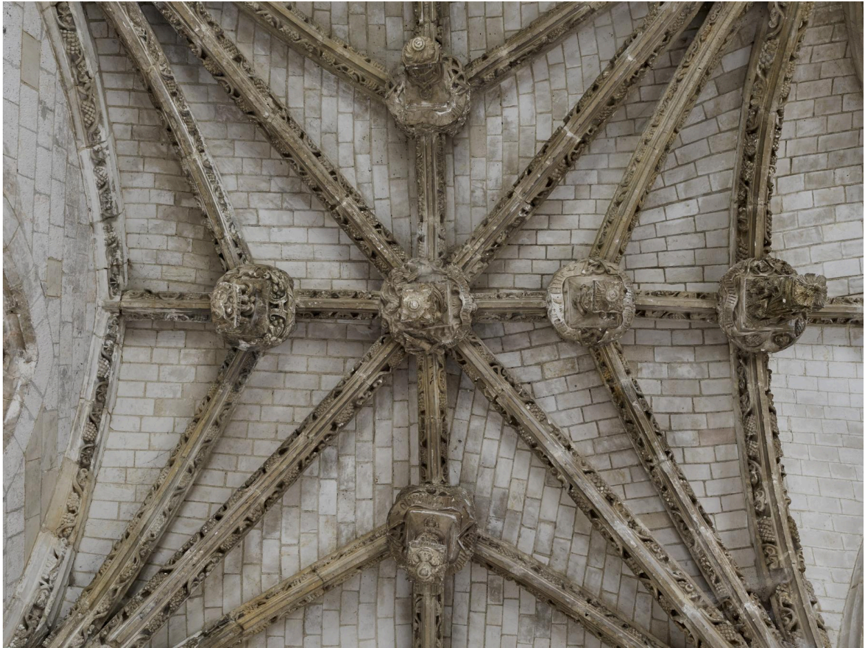
Voûte de la chapelle de la Vierge, première travée côté ouest.
