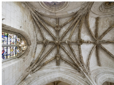
Voûte de la chapelle de la Vierge, première et seconde travée est. Phot. Thierry Lefébure IVR32_20238000353NUCA
