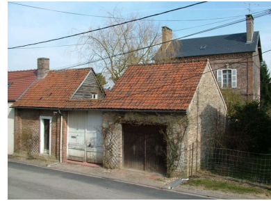
Vue générale depuis la rue. Phot. Frédéric Fournis IVR22_20108001107NUCA
