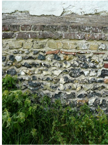
Vue détaillée du solin. Phot. Inès Guérin IVR22_20078005881NUCA
