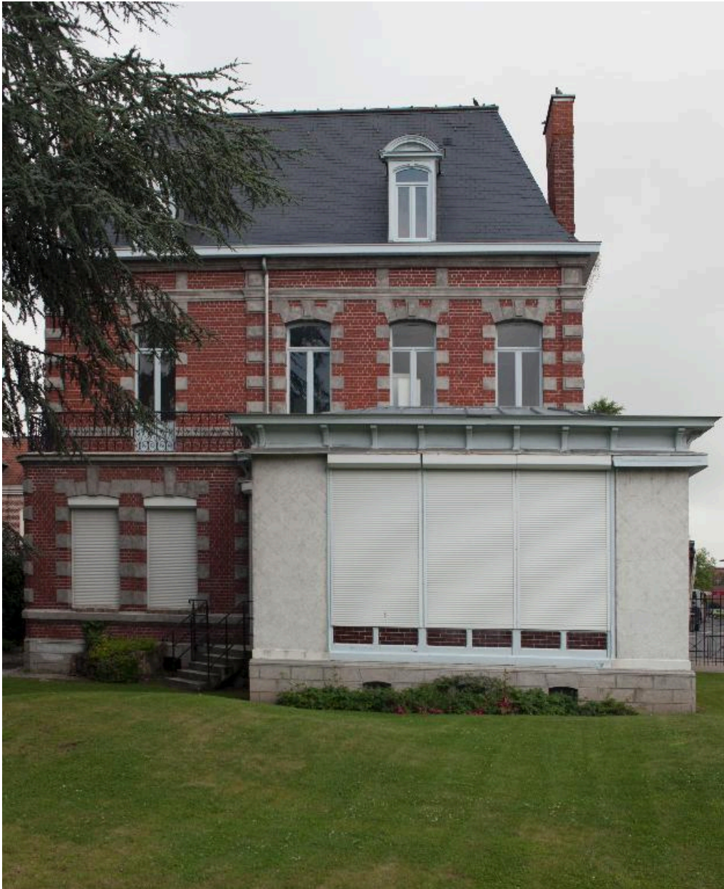
Vue générale de la façade postérieure.
