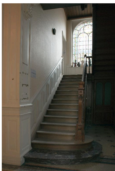
La cage d'escalier depuis le rez-de-chaussée. Phot. Pierre Thibaut IVR31_20125901939NUCA
