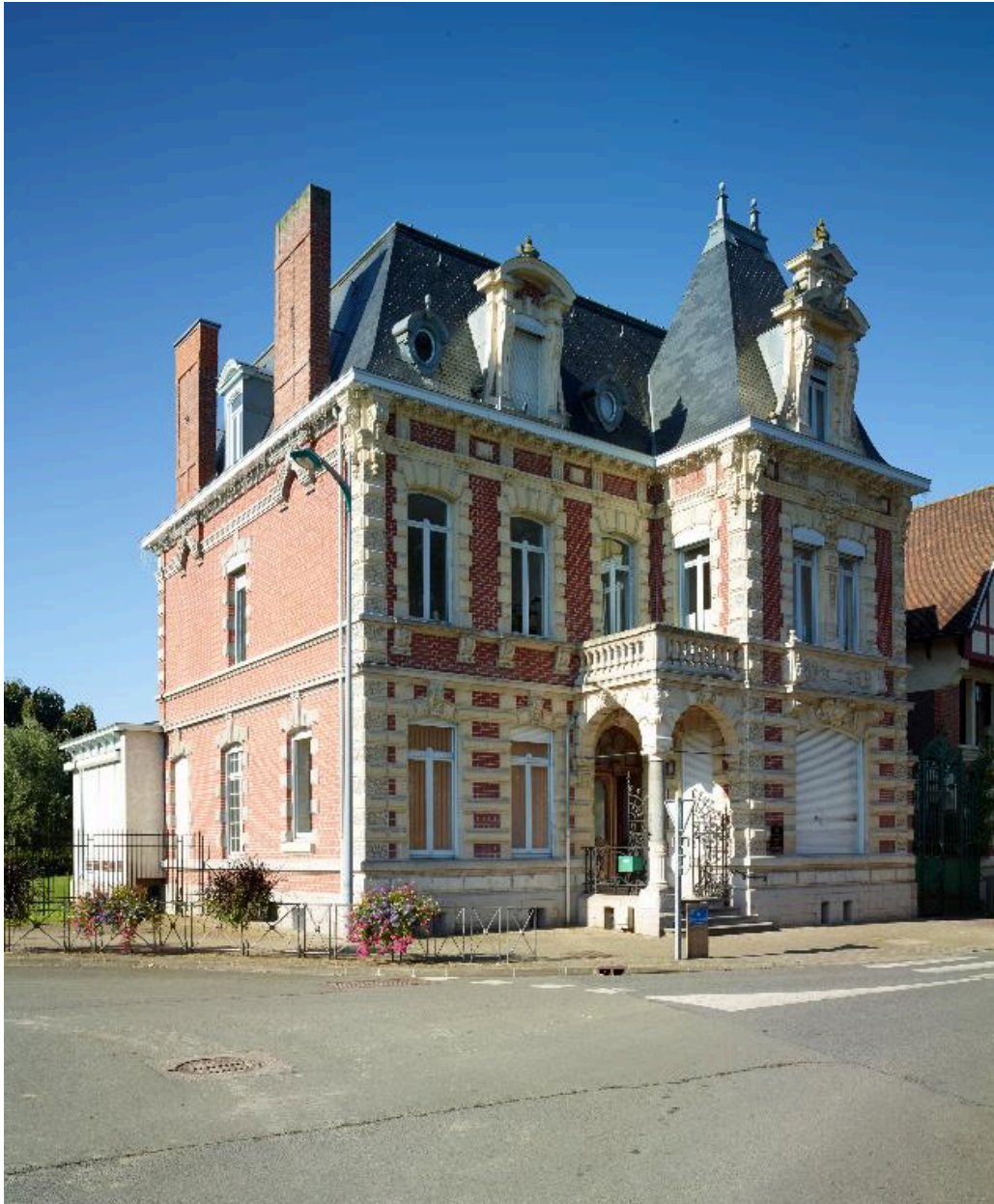
Vue générale depuis la rue Mathieu-Dumoulin.
