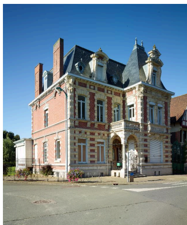
Vue générale depuis la rue Mathieu-Dumoulin. Phot. Pierre Thibaut IVR31_2015590141NUCA
