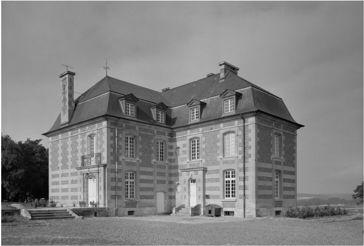
Château. Elévation antérieure.
