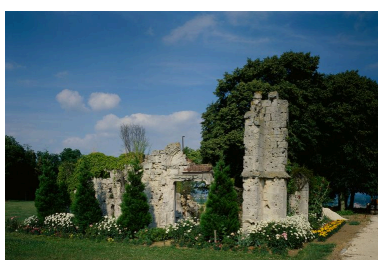
Vue de la chapelle en ruines (AP). Phot. Fabrice Charrondièrre IVR22_19866000148XA
