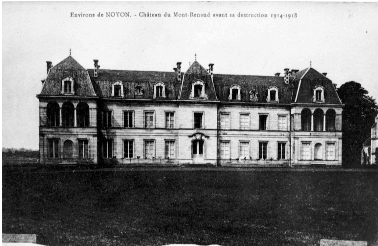
Elévation postérieure du château avant 1914 (AP).
