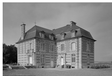
Château. Elévation antérieure. Phot. Fabrice Charrondièrre IVR22_19866000128X
