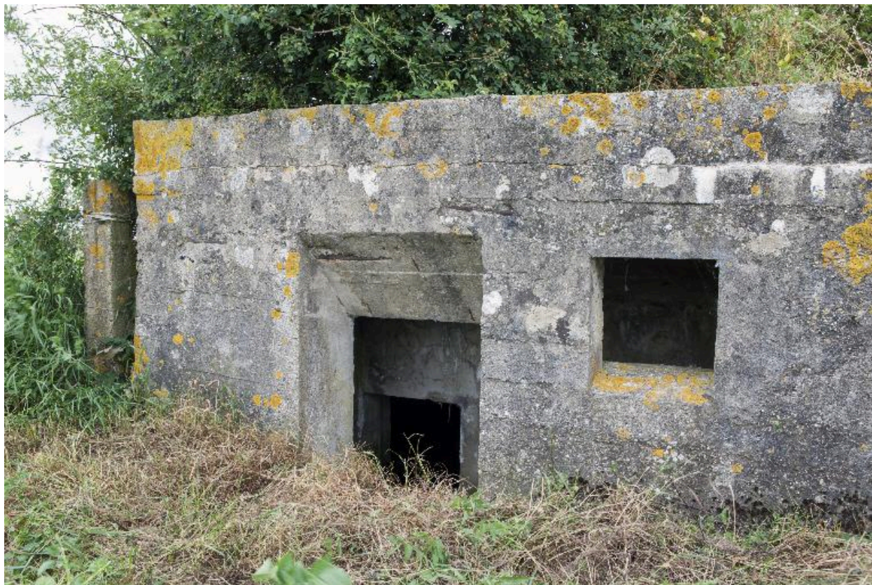
Entrée vers le nord-ouest. Accès au couloir et à la salle ouest de l'abri
