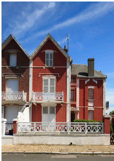
Façade sud (détail). Phot. Hubert Bouvet IVR31_20136200161NUCA
