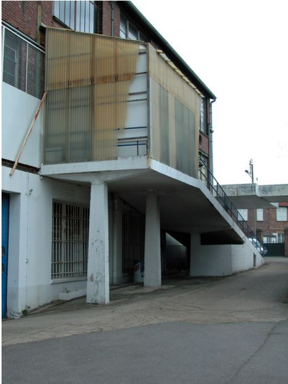
L'escalier de la façade sud.
