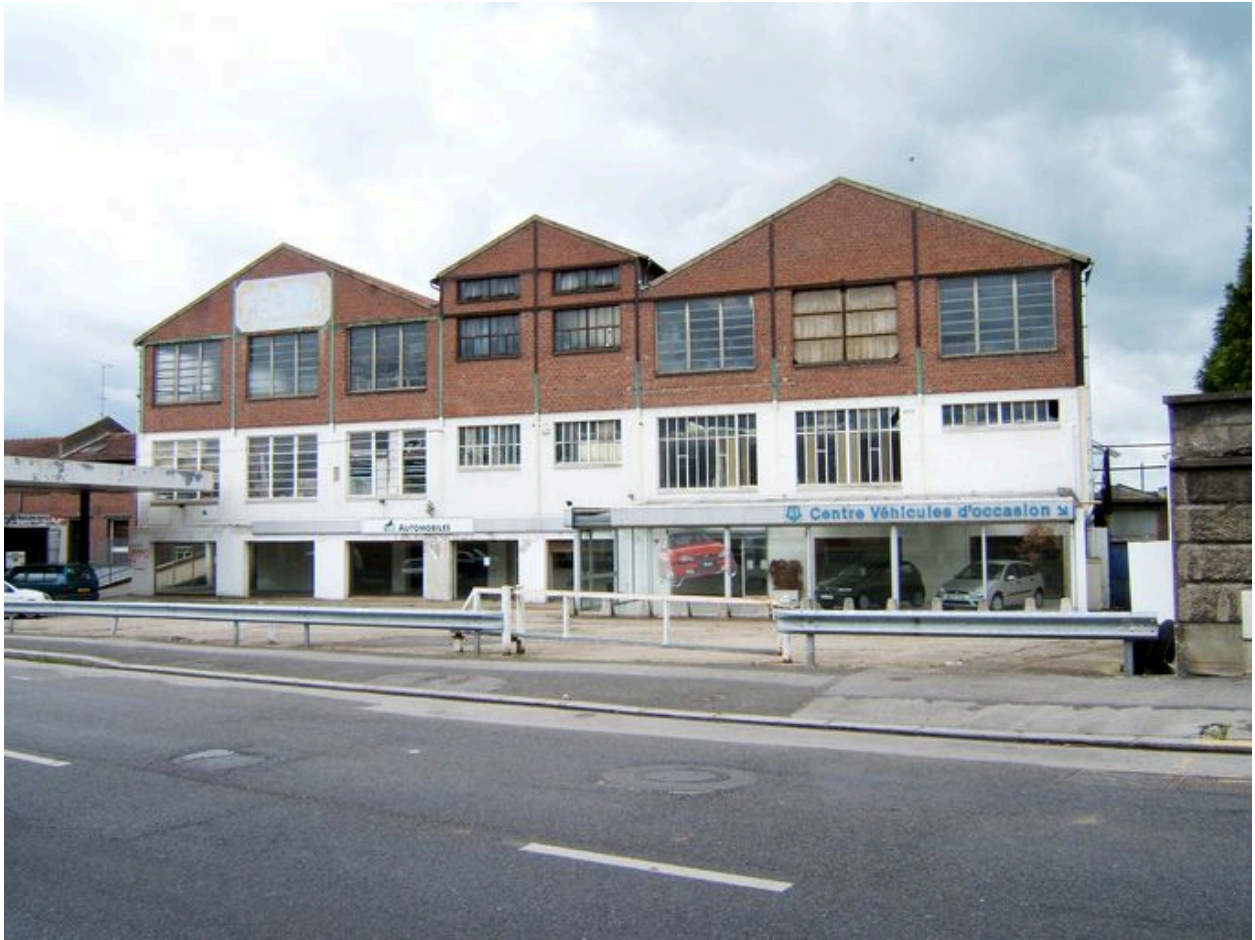
Façade est donnant sur la rue.
