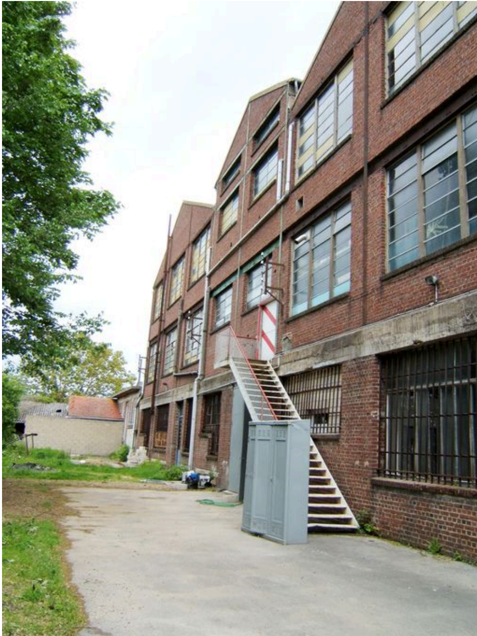
Vue latérale de la façade ouest.
