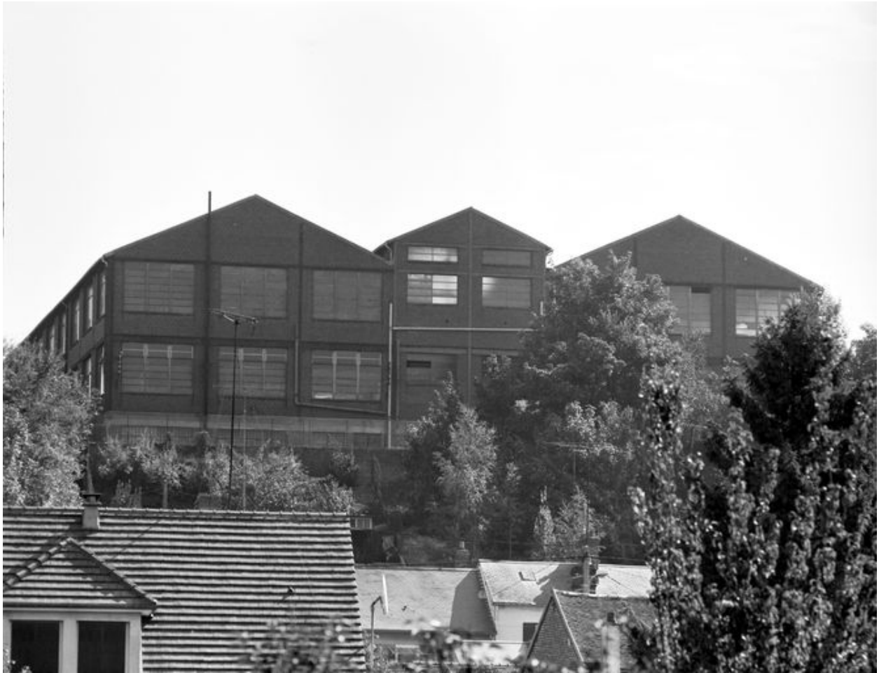
Façade ouest de l'usine.
