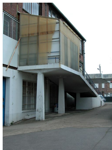
L'escalier de la façade sud. Phot. Bertrand Fournier IVR22_20066090071NUCA
