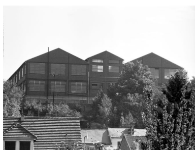
Façade ouest de l'usine. Phot. Laurent Jumel IVR22_19966002707X
